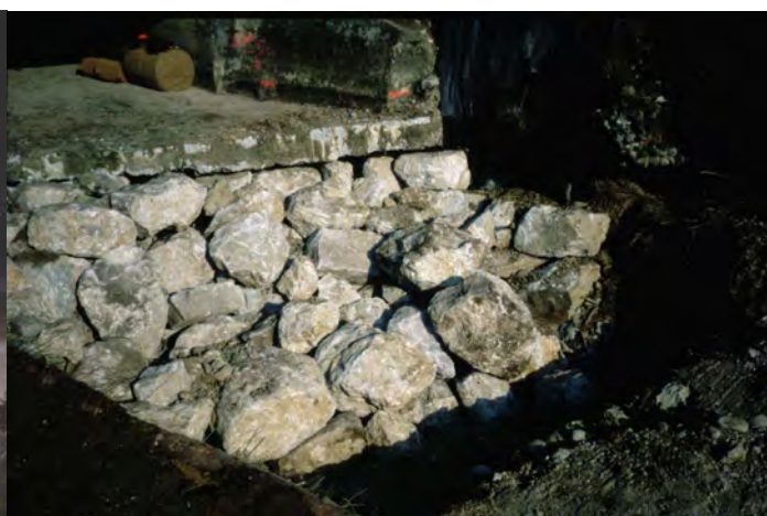
Réparation du radier
