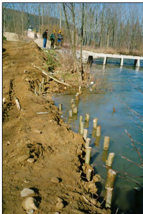
Pendant travaux : pieux prêts à recevoir le fascinage
