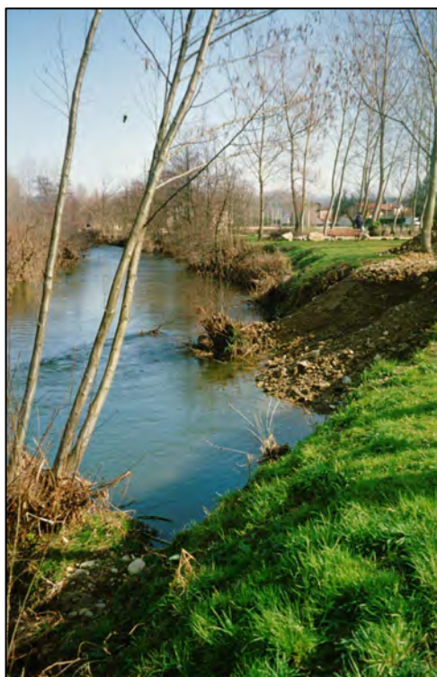
Avant travaux : vue de la berge fortement érodée
