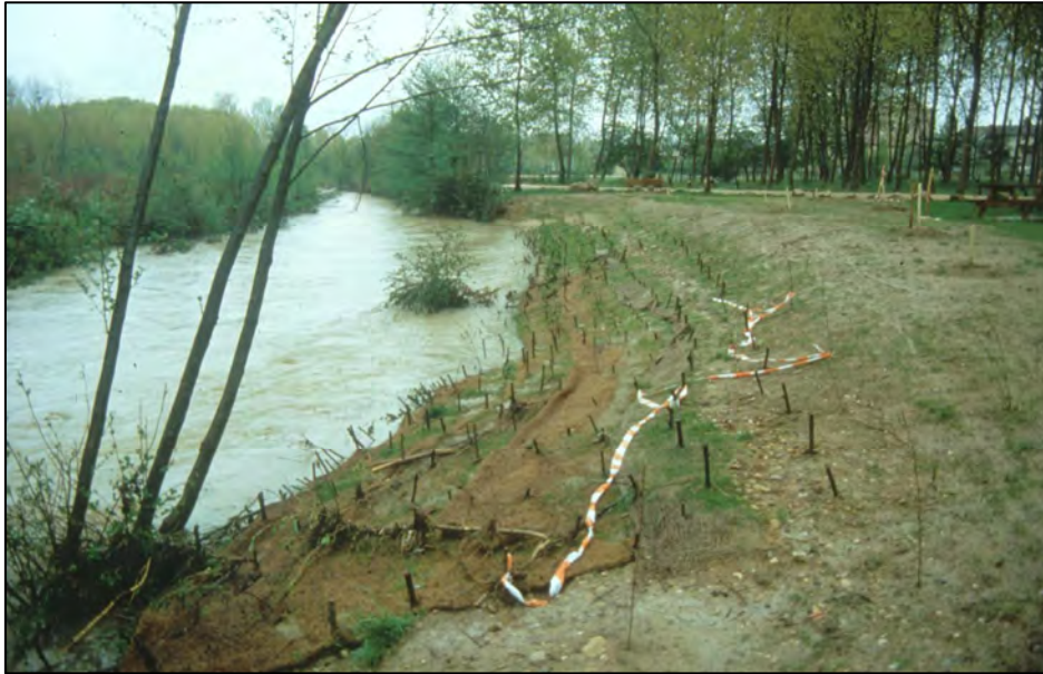
Avril 95 : ouvrage terminé juste après une crue débordante
