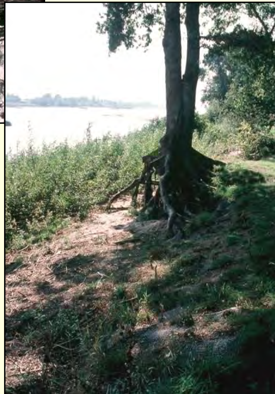
Un manque de travaux préparatoires
