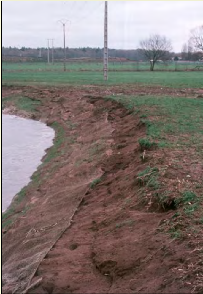
Une mauvaise appréciation des courants de débordements
