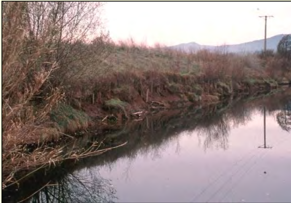
Un mauvais calage des ouvrages
