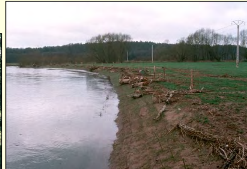
Un défaut d'entretien des ouvrages
