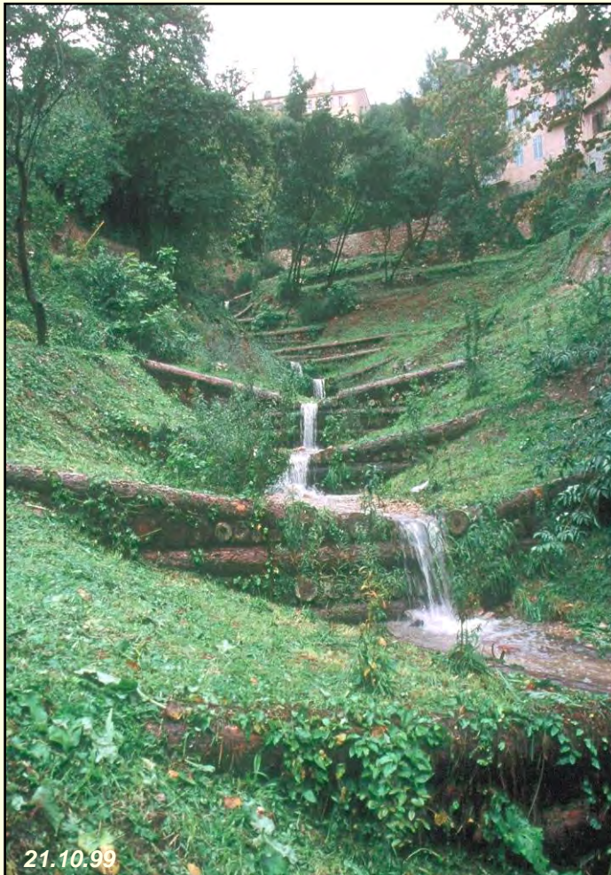
Six mois après les travaux
