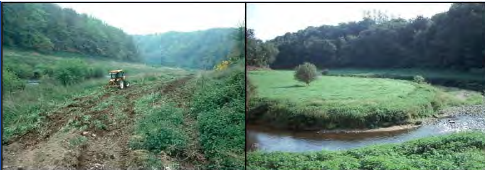
Vue des travaux de labour en cours dans l'emprise de l'ancienne retenue sur la photo de gauche (09.05.2001) puis des prairies riveraines fraîchement reconstituées en bordure du Légier à droite (07.09.2001). Conception des aménagements de l'ancienne retenue et photos Biotec.
