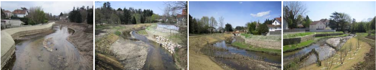
Premières réalisations à Charbonnières-les-bains courant 2013 - Photos SAGYRC
