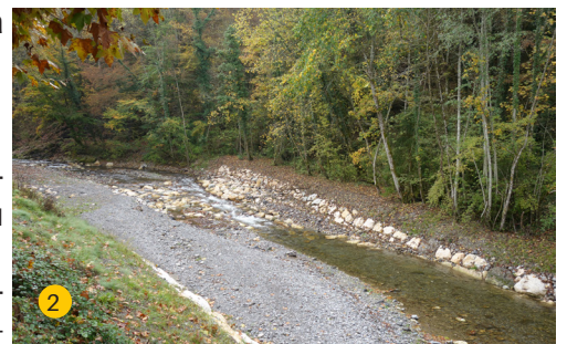
Rivière dans Faverges après restauration
