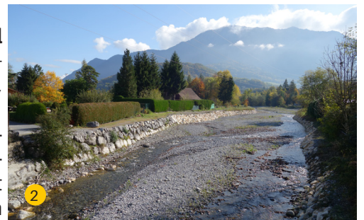
Rivière dans Faverges après restauration
