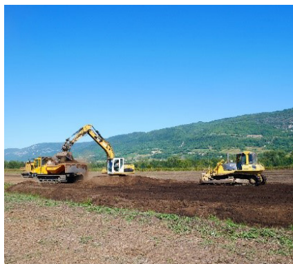
Terrassement (étrépage de la couche superficielle pour comblement des fossés)
