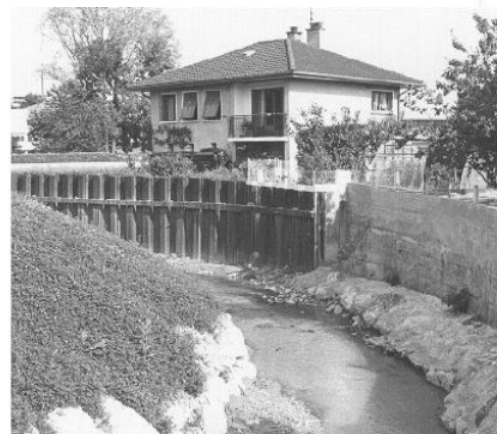
Confortement des berges dans les secteurs urbanisés
