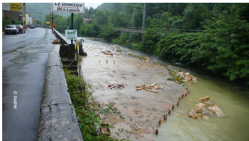
Travaux sur l'ALBARINE
