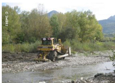
Scarification au bull avec dents ripper
