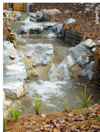
Passé à poissons sur la Véore
