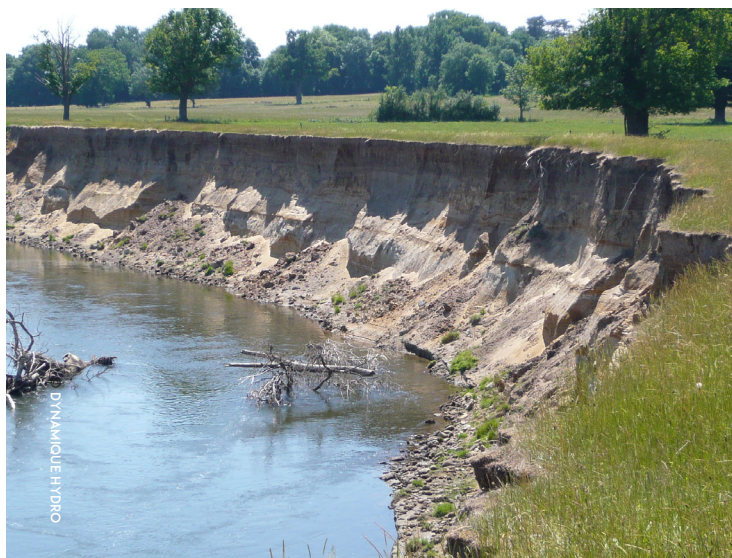
Erosion de berges sur l'Allier
