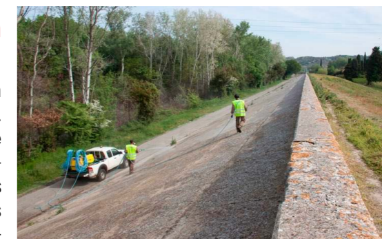
Visite de surveillance des digues du SYMADREM
