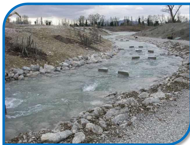
Rivière de contournement sur le seuil de Livron/Drôme (26) – pente inférieure à 2 %
