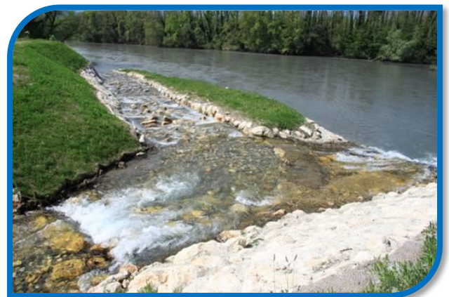
Ouvrage de décharge sur la passe de la Combe de Lancey
