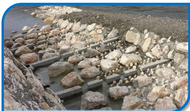
La confluence de la Combe de Lancey (38) : la passe hors d'eau, les barrettes béton, les micro et macrorugosités
