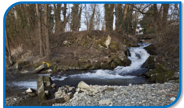
La confluence de la Combe de Lancey (38) : état initial
