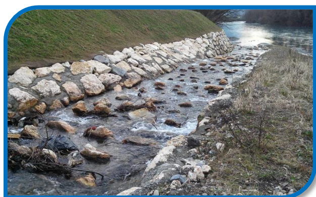
Rampe en enrochement régulièrement répartis sur le ruisseau de la Combe de Lancey (38) – pente à 6-7 % - passe adaptée au Chabot
