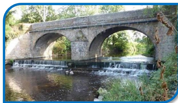
Le Pont des Allées : état initial
