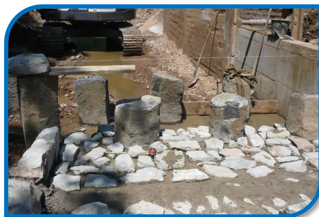
Réalisation d'une planche d'essai sur le Pont des Allées
