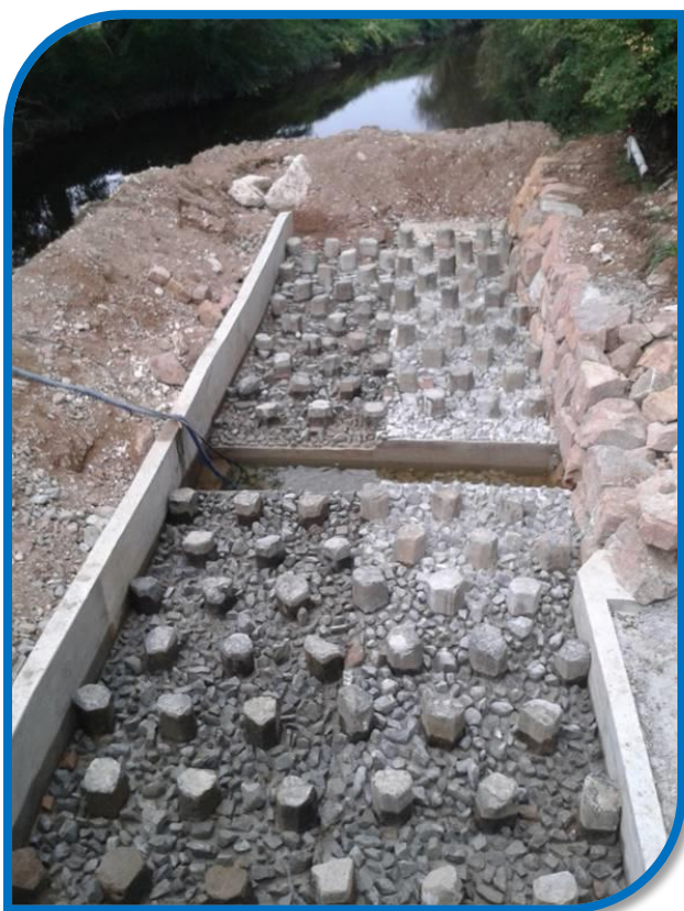
Pompage des venues d'eau dans les zones de repos en cours de réalisation
