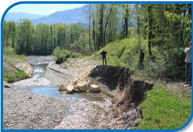
Érosion liée à une mauvaise connaissance des conditions hydrologiques du bassin versant
