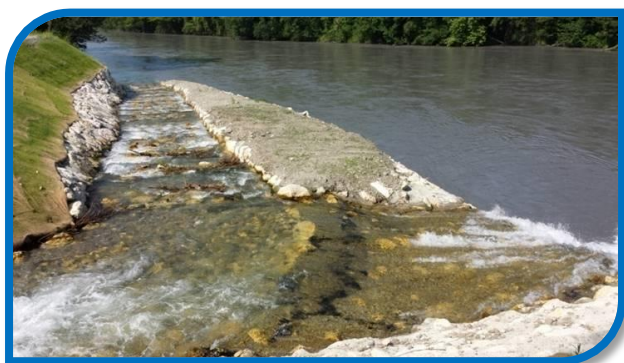
La confluence de la Combe de Lancey (38) : la passe en eau et le déversoir
