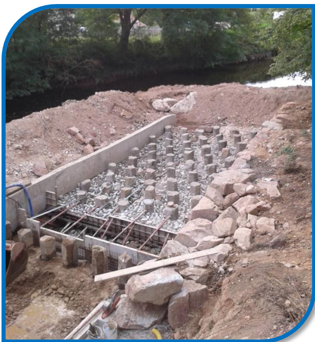
Réalisation du corps de rampe et de la zone de repos
