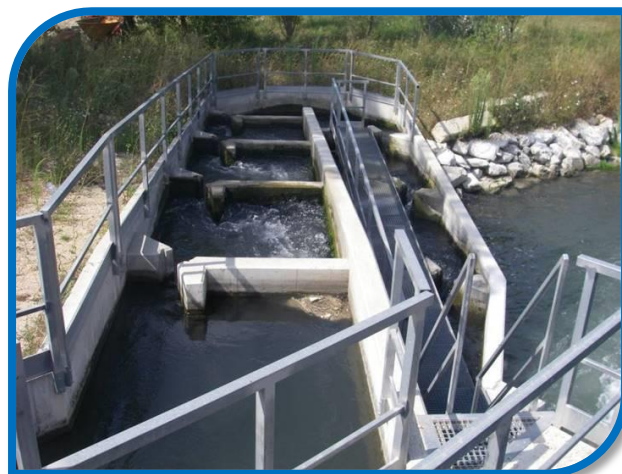
Passe à bassins successifs repliée pour optimiser son emprise au sol
