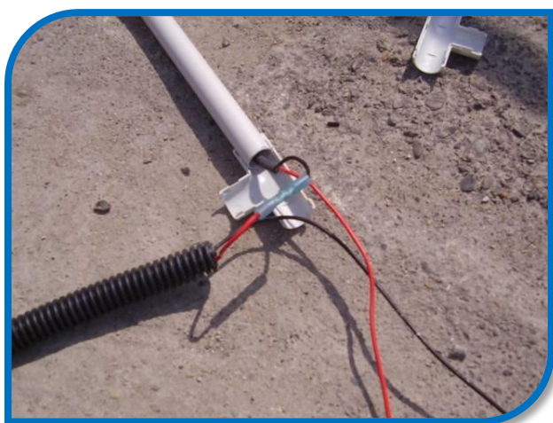
Montage de l'antenne de détection des transpondeurs avant positionnement (source : EDF)
