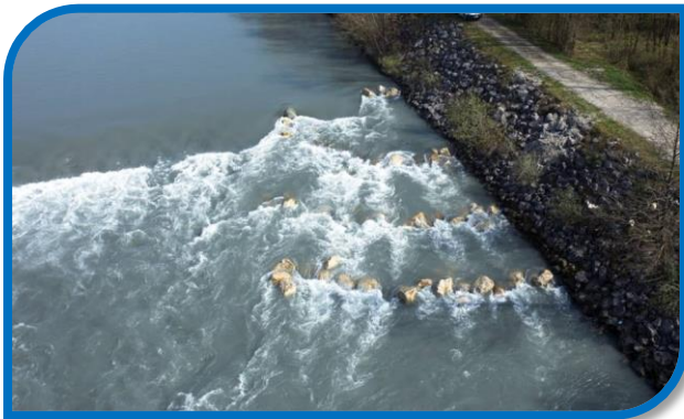
Le seuil de Goncelin (38) aménagé à l'aide de blocs disposés en rangée en rive gauche
