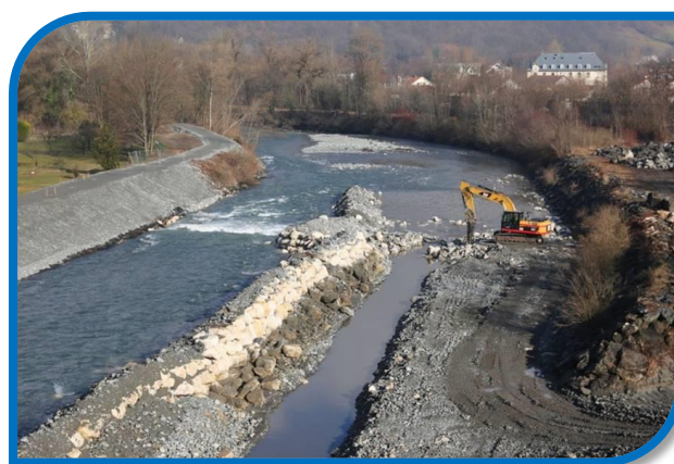
Travaux d'arasement du seuil Tardy sur la Romanche avec réalisation d'un demi-batardeau
