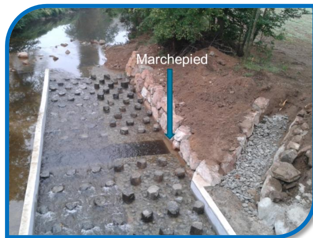
Dernières finitions et mise en eau de la rampe
