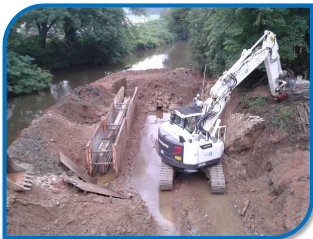
Coffrage du voile avant mise en œuvre du béton
