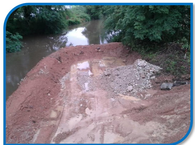
Création d'un batardeau en vue de la mise à sec de la zone de travail (source : SYRRTA)
