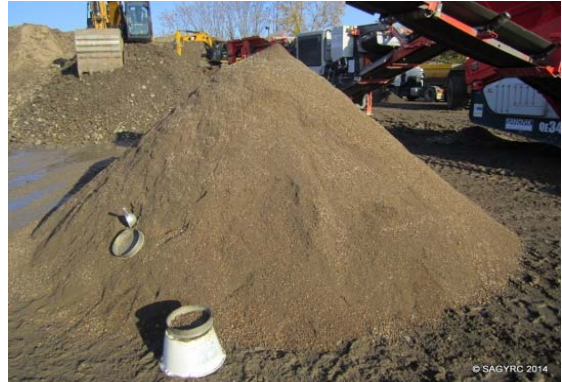
Matériaux sortie crible : fraction 0/20mm dépourvue de rhizomes
