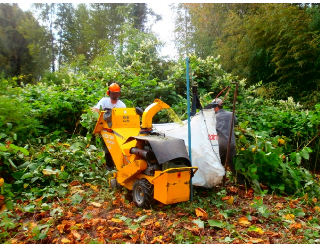
Fauchage/broyage des tiges aériennes avant terrassement
