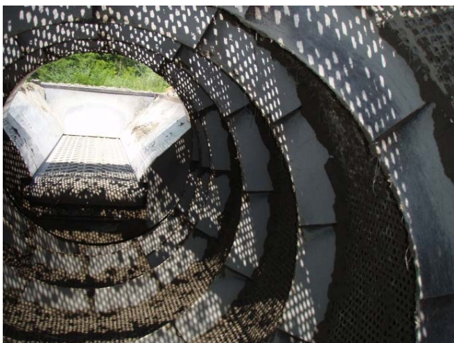
Vue de l'intérieur du crible (vis sans fin)
