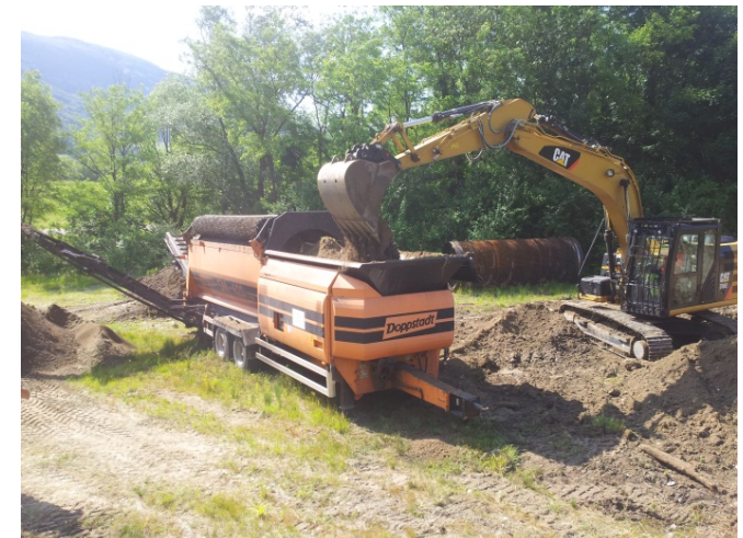
Vue d'ensemble de l'atelier
