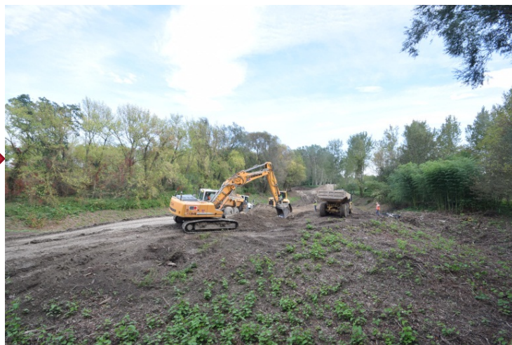
Déblais des matériaux contaminés avant l'ensemble des terrassements
