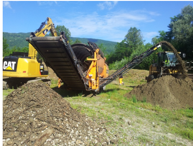
Vue d'ensemble de l'atelier
