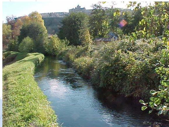
Etude d'optimisation de l'eau par l'irrigation / Restauration de canaux / passage sous pression
