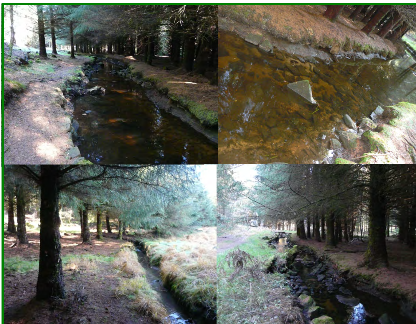
Figure 2 - Problèmes hydromorphologiques recensés sur le ruisseau de Chamboux
