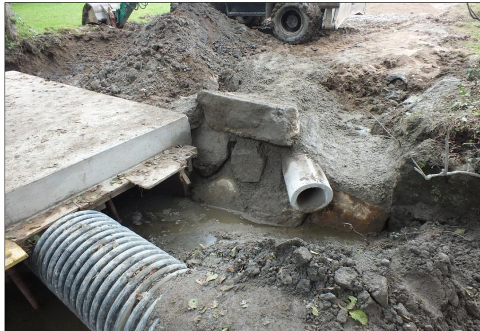
Mise en œuvre des enrochements liaisonnés
