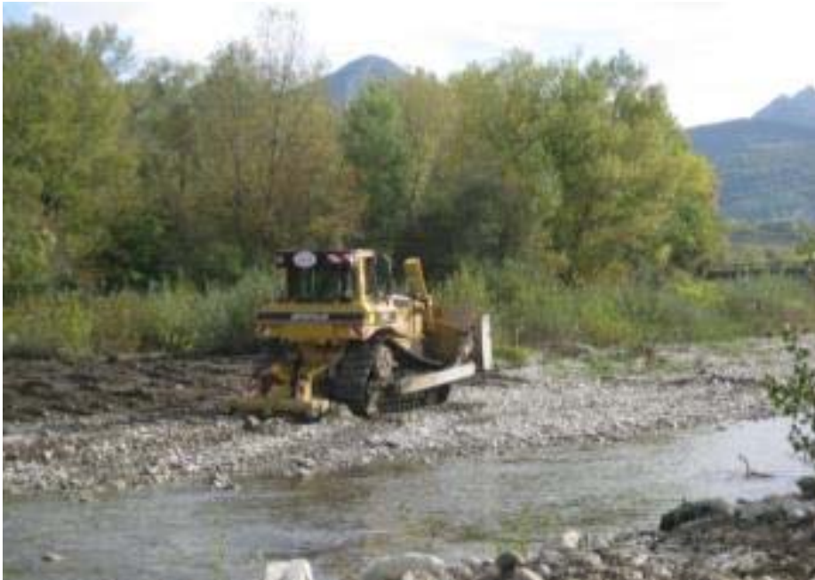
Scarification au bull avec dents ripper
