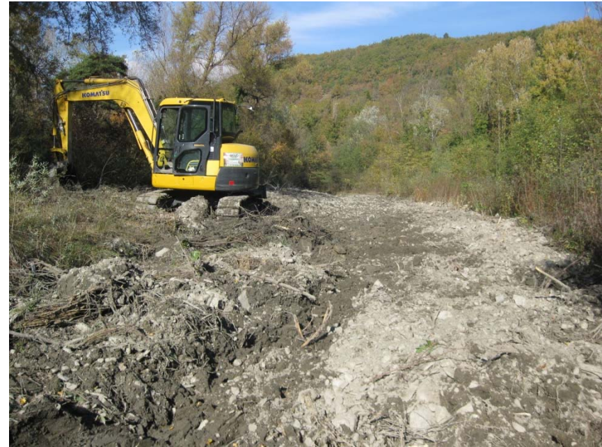
Scarification à la pelle par piochage
