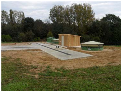
Aire de lavage des pulvérisateurs
