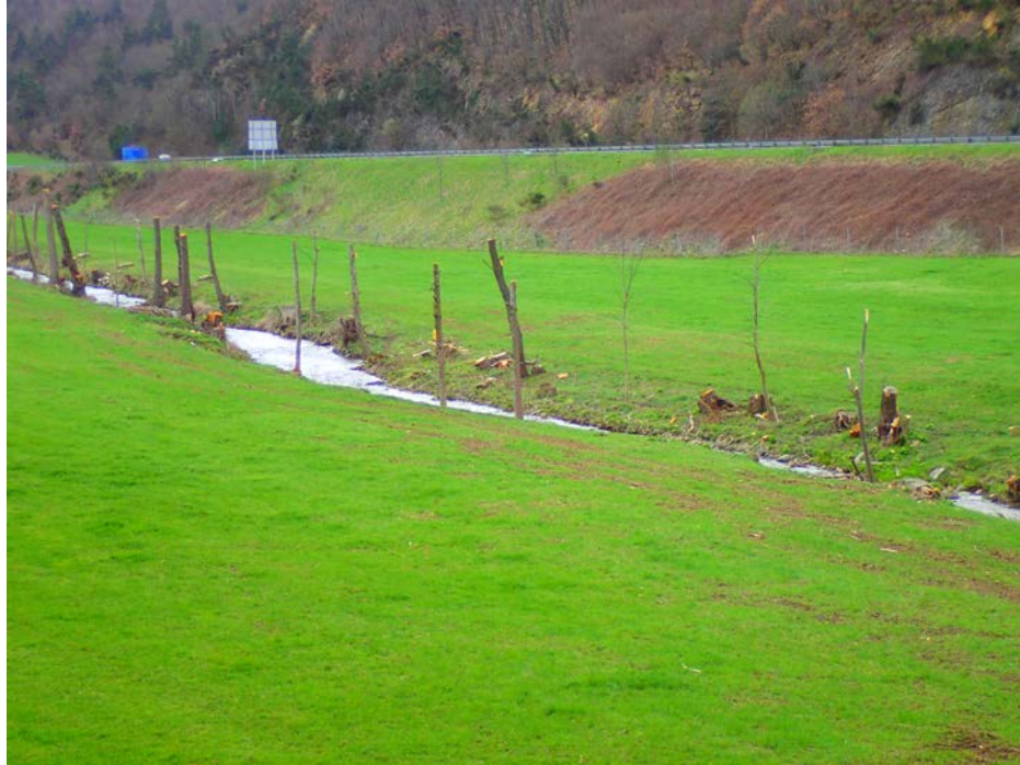
Linéaire coupé trop long & sur deux rives Souches mal coupées au ras du sol
