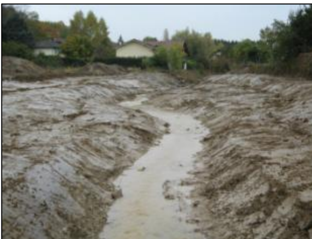
Pendant travaux : emprises foncières plus importantes, suppression des ouvrages béton, création de sinuosités, berges en pente douce, élargissement de la section d'écoulement, plantations
