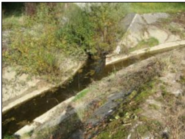
Avant travaux : secteur canalisé, section d'écoulement insuffisante, aucun habitat, végétation quasi inexistante
