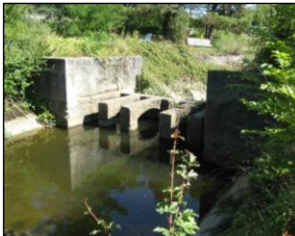
Avant travaux : secteur canalisé, section d'écoulement insuffisante, aucun habitat, végétation quasi inexistante
