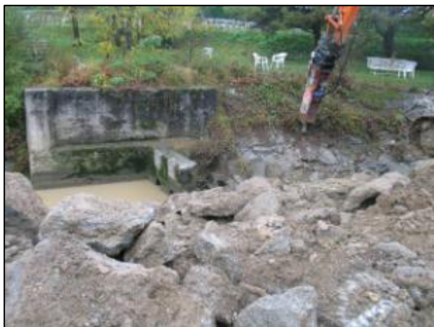
Pendant travaux : emprises foncières plus importantes, suppression des ouvrages béton, création de sinuosités, berges en pente douce, élargissement de la section d'écoulement, plantations
