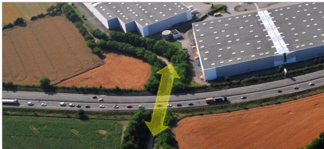
point de passage n°49_1 entre la Plaine du Biezin – Est et la Plaine Saint- Exupéry, commune de Meyzieu
