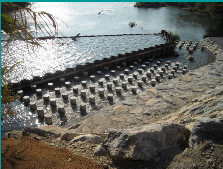
Seuil de Callet sur le Gardon
