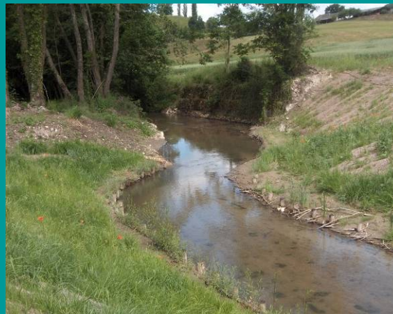
Barrage supprimé sur la Méline
