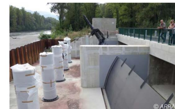
Ouvrage hydraulique alimentant le CIC à Domène. Il est équipé d'un clapet de sécurité avec un détecteur de niveaux actif pour une crue trentennale
