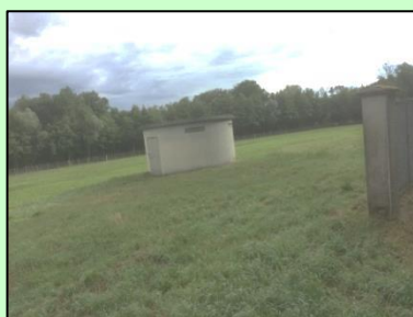
Captage en zone humide avec entretien du périmètre rapproché par la fauche (protection de la ressource).
