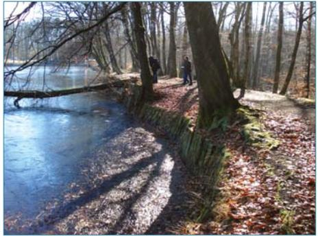
*Figure 4.10. Arbres de haute tige, au port dangereusement penché, se développant au-dessus du niveau normal des eaux d'un petit barrage d'étang et ayant tendance à déstructurer la protection anti-batillage, ici par pieux-bois (ph. P. Mériaux).*
