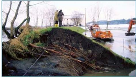
Figure 1.17b. L'érosion de cette digue du Danube, lors des crues de 1988, révèle des racines venant des arbres visibles à gauche, et ayant traversé le remblai de part en part à la recherche de l'eau du côté rivière. On notera le fort diamètre d'une des racines relativement à celui des troncs. Le déracinement d'arbres proches de la crête a été à l'origine de plusieurs brèches au cours de cette crue (ph. C.H. Ifft, USACE).
