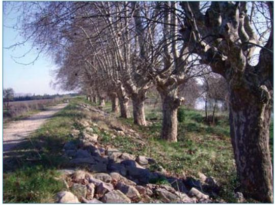
*Figure 5.3. Gros platanes en alignement sur le ségonnal d'une digue du Vidourle. Les racines de ces arbres peuvent traverser de part en part les soubassements de la digue, comme illustré par la figure 1.16 (p. 39). Leur déracinement lors d'une crue ou d'une tempête, bien qu'assez peu probable, déstabiliserait le pied du talus (ph. M. Vennetier).*
