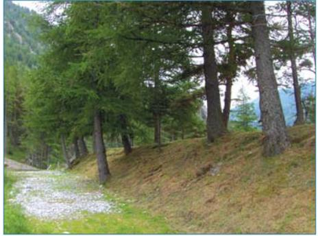
*Figure 3.19. Couvert arboré moyen à dense dominant une pelouse sur digue étroite. L'élimination des arbres, dont le système racinaire occupe tout le remblai avec de grosses racines traversantes, implique à terme la rénovation complète de l'ouvrage (ph. C. Zanetti).*
