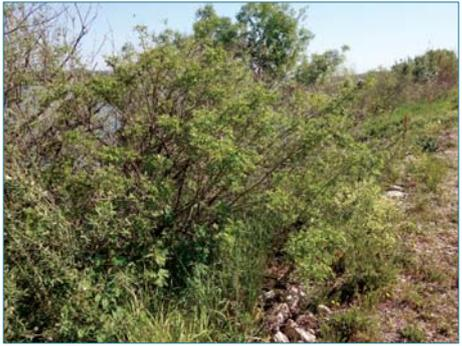
*Figure 3.18. Couvert arbustif dense gênant l'inspection visuelle. Le retour à une situation satisfaisante (type 2) peut être rapide et n'impose pas de travaux de réfection du remblai (ph. M. Venetier).*
