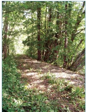
Figure 5.11. L'abandon de l'entretien courant des digues après 1970 avait conduit au développement d'une forêt luxuriante sur une grande partie des talus (ph. C. Ripert).
