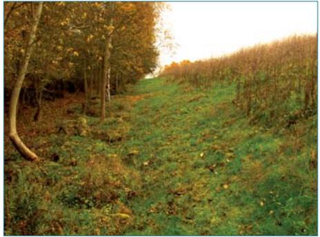
Figure 4.5. Haie d'arbres trop proche du pied de parement aval d'un barrage, avec troncs poussant au débouché du tapis drainant (ph. P. Mériaux).
