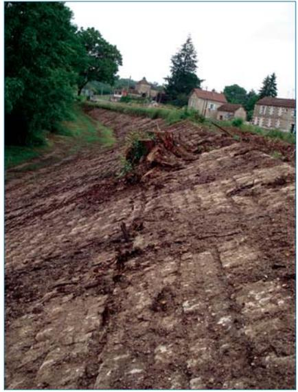
Figure 1.7. Colonisation par des racines d'arbres d'un joint ouvert de perré maçonné. Amorces de déstructuration pouvant aboutir à un large trou dans l'ouvrage en cas de déracinement de l'arbre (ph. C. Zanetti).
