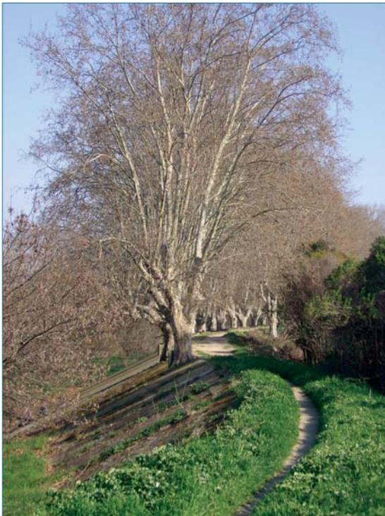
*Figure 1.20. Alignement de platanes centenaires sur une crête de digues à charge temporaire. Un perré bétonné protège le talus côté fleuve mais il est par endroits soulevé par les racines. Le système racinaire de ces platanes occupe la totalité du corps de digue. Leur déracinement provoquerait une loupe d'arrachement au moins équivalente, en proportion, à celle de la figure 1.19 (ph. M. Venetier).*
