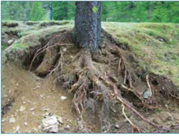
Figure 1.17a. Sur la gauche de cet arbre en cours de dégagement, une énorme racine (diamètre 25 cm, flèche blanche) s'enfonce en plongeant vers le cœur de la digue. Sa taille, surdimensionnée par rapport aux autres racines, indique qu'elle a probablement atteint le sol et la nappe sous le remblai ou de l'autre côté de l'ouvrage et joue un rôle clef dans l'alimentation de l'arbre. Sa décomposition laisserait une galerie de gros diamètre dans la digue (ph. C. Zanetti).
