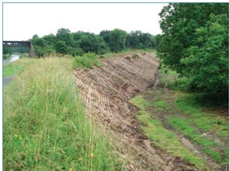
Figure 3.5. Digue de la Loire avec perré maçonné. Noter les rejets de souche d'arbres poussant directement dans le perré et récemment coupés (ph. C. Zanetti).
