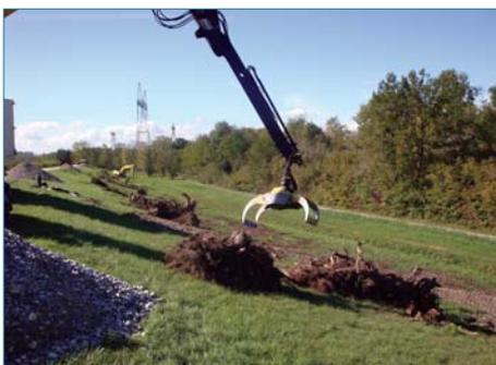
Figure 5.19. Pendant travaux de dessouchage (ph. C. Zanetti).
