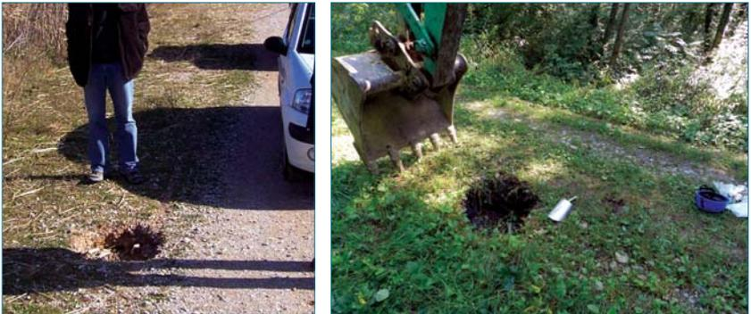
Figures 4.8. Fontis d'origines différentes sur une crête de digue résultant : (a) d'écoulements internes lors d'une crue récente (photo prise lors d'un examen visuel post-crue), (b) de la probable décomposition d'une grosse souche pour cette digue située en environnement boisé (photos P. Mériaux).
