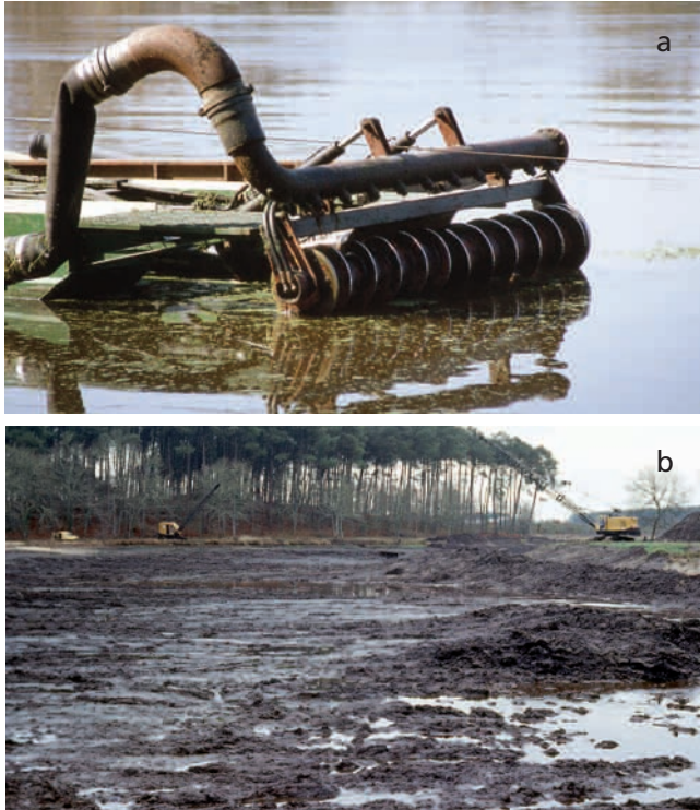
(a) Dragage de l'étang de Moysant (Landes). (b) Curage de la retenue des Forges à Ychoux (Landes).
