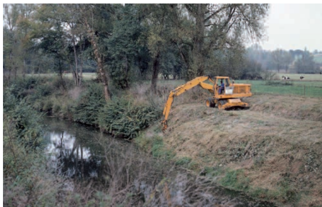
Traitement à l'épaveuse d'une berge de cours d'eau (Dropt, Gironde).
