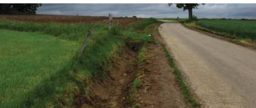
Fossé «classique» avec réduction de section
