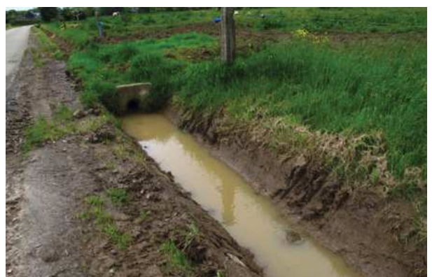
Fossé «classique» avec réduction de section
