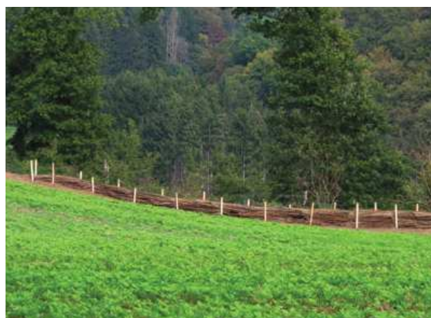
Finition des bords de la fascine par un ados de terre. Semis d'herbe sur les zones de terre nue.
