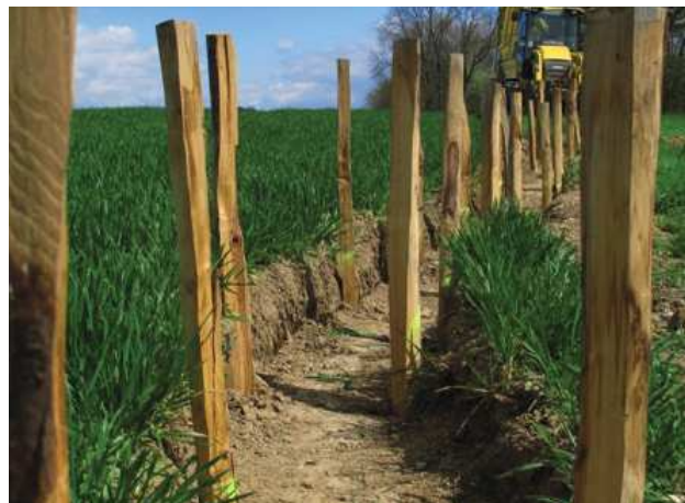
Creusement de la fosse, avec un godet adapté à la largeur des fagots
