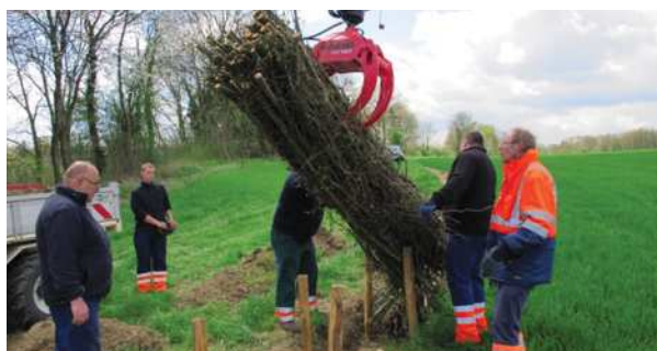
Mise en place des fagots, à la main ou à la grue selon la taille. Attention à la qualité des fagots: branches fines!
