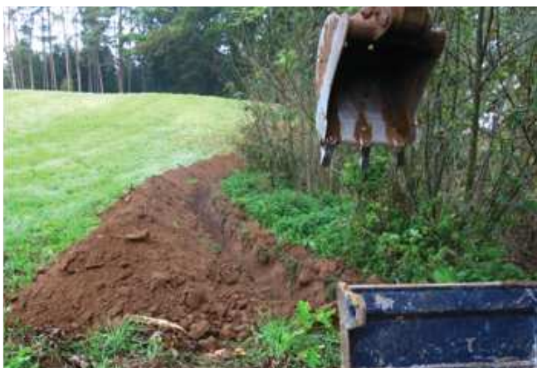
Creusement de la fosse, avec un godet adapté à la largeur des fagots
