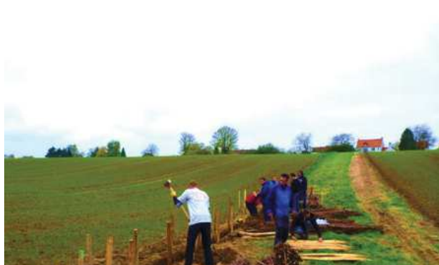
Disposition des piquets, enfoncement, à la masse ou à la machine, rectification de la fosse à la bêche si nécessaire.
