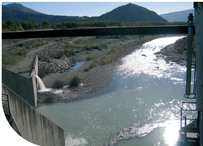
Buech - Barrage EDF Saint Sauveur
