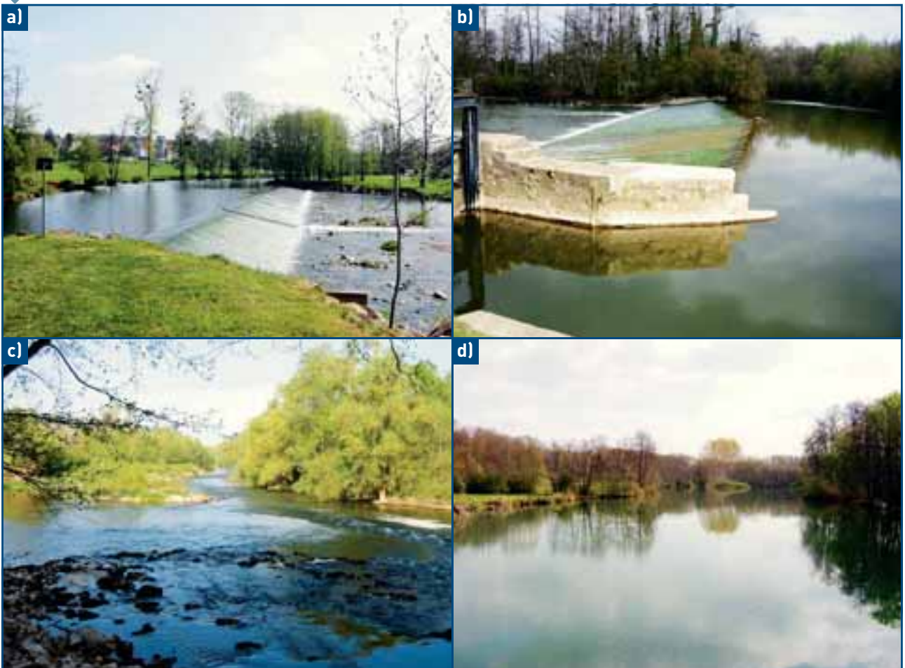
↓ Figure 35 : a) et b) Exemples de seuils. c) Portion naturelle relictuelle présentant des faciès d'écoulement et des milieux diversifiés (bancs alluviaux diversement végétalisés). d) Vue « classique » de la retenue générée par l'ouvrage : un faciès lentique homogène sur plusieurs centaines de mètres. ≡
