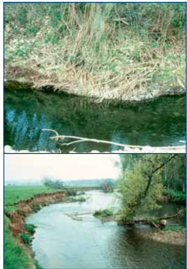
↑ Figure 26 : En haut, racines d'aulne glutineux ( Alnus glutinosa ), espèce végétale particulièrement adaptée aux bordures de cours d'eau. En bas, embâcles formés par des cultivars de peupliers ( Populus x nigra ) facilement déchaussés en raison de leur faible développement racinaire d'une part et de leur port élevé d'autre part, favorisant une grande prise. ≡
