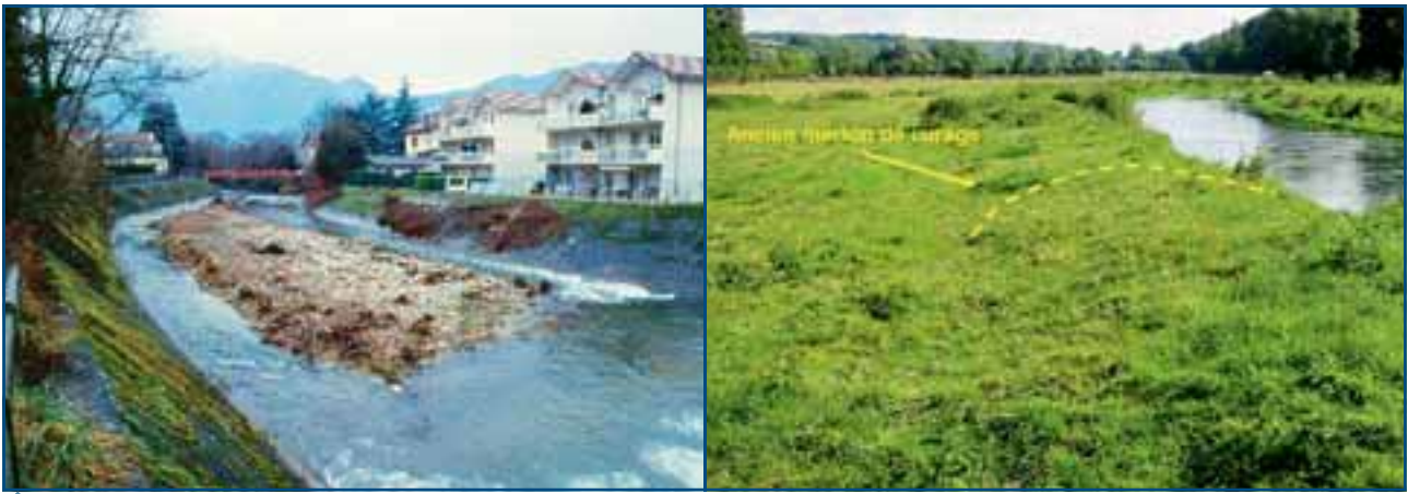
↑ Figure 31 : A gauche, endiguement en béton sur les deux berges en zone urbanisée. A droite : ancien merlon de curage en bordure de la Scie (76). ≈
