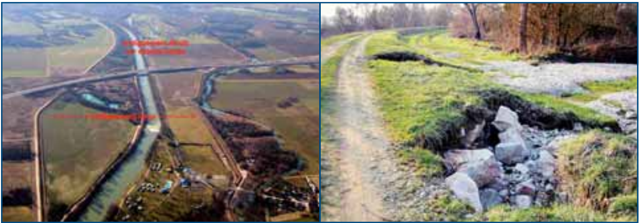
↑ Figure 32 : A gauche, vue aérienne d'un système à double endiguement en zone rurale (protection des cultures). Etroit pour les crues fréquentes et large pour les crues plus rares. A droite, exemple de digue en enrochements + remblai (la rivière est à gauche). ≈
