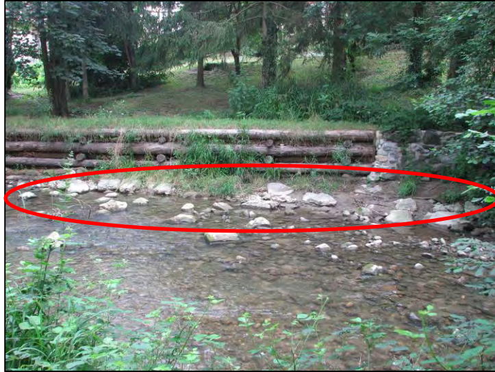
Enrochement à l'avant de l'ouvrage (partie amont du caisson). Cet enrochement est enfoui sous le niveau du lit. (Source : MATRINGE, 2008)
