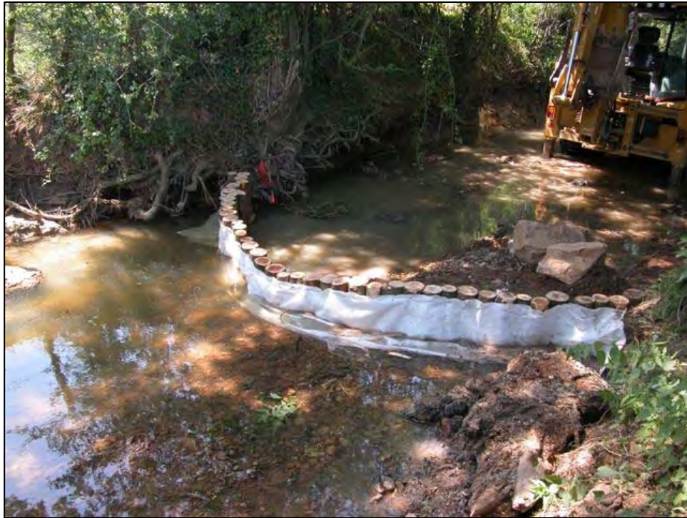
Pieux jointifs en arc de cercle (partie convexe vers l'amont pour recentrer les écoulements). On peut observer le bidime routier pour l'étanchéité. (Source : C.C. Pays de Charlieu)
