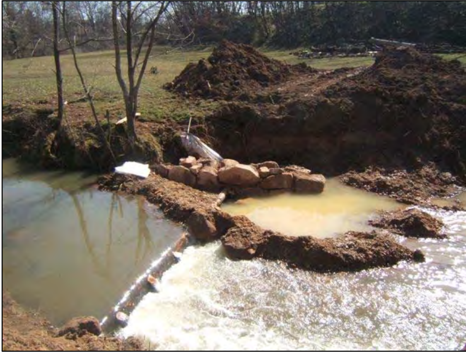
Ancrage de l'ouvrage dans la berge à l'aide d'énrochements. (Source : C.C. Pays de Charlieu)
