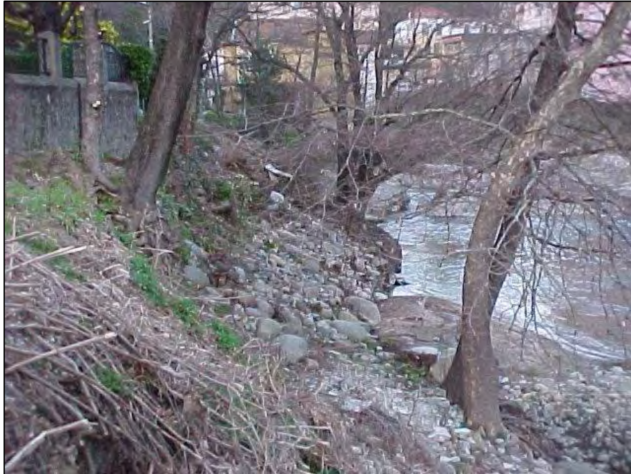
Site avant travaux (Source : Syndicat Ardèche Claire)
