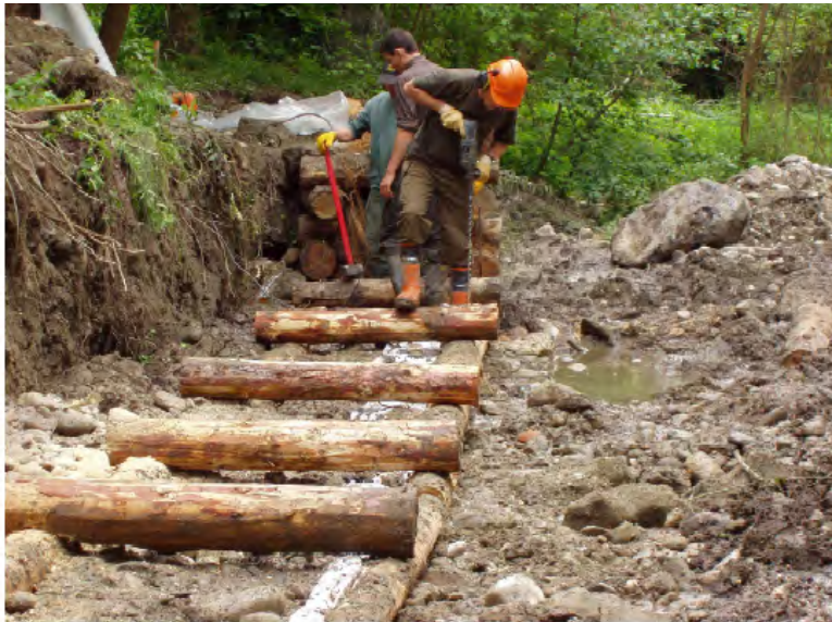
Assemblage des troncs (Source : http://www.sicheran.com/index.php?rub=13 « Protection berge Nephaz Rumilly.pdf »)
