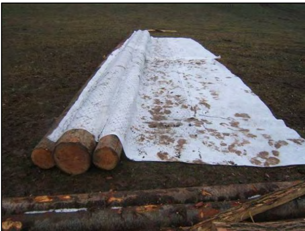
Les 3 troncs transversaux, liés entre eux. On remarque le bidime routier pour assurer l'étanchéité. (Source : C.C. Pays de Charlieu)
