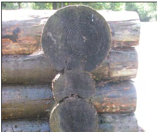
Bois entaillés dans le sens de la longueur (Source : MATRINGE, 2008)
