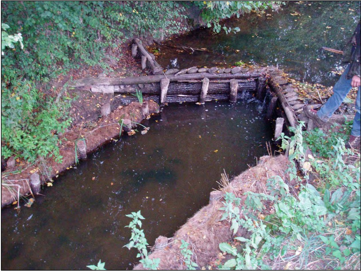
Seuil avec fascine en aval (Cliché : Syndicat de la Reyssouze)
