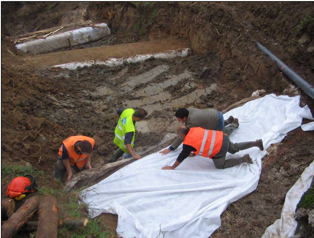
Installation du bidime par dessus le remblai compris entre deux longrines. L'ouvrage se situe en sortie des buses de franchissement de la RD7 (Source : Département du Rhône, Brigade verte)
