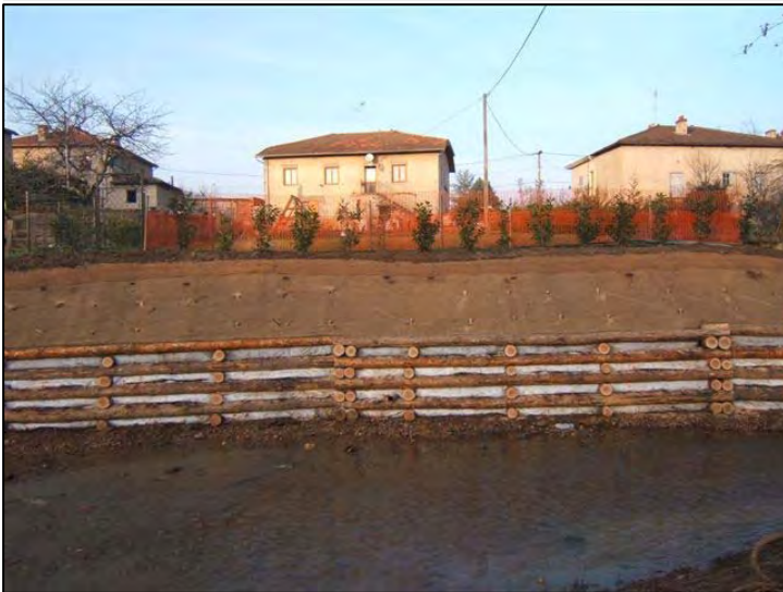
Fin des travaux. (Source : C.C. Pays de Charlieu)
