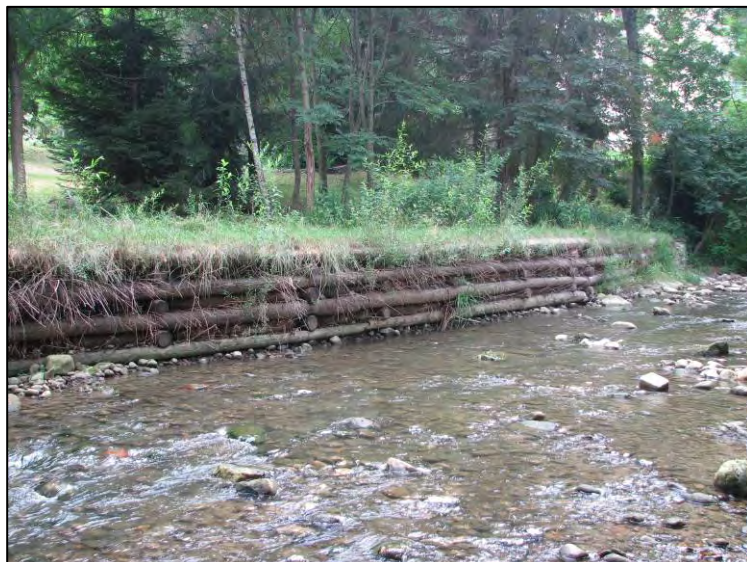
État du caisson en 2008 : La reprise des saules n'est pas complète. En sommet de caisson, les graines de semis ont germé. (Source : MATRINGE, 2008)
