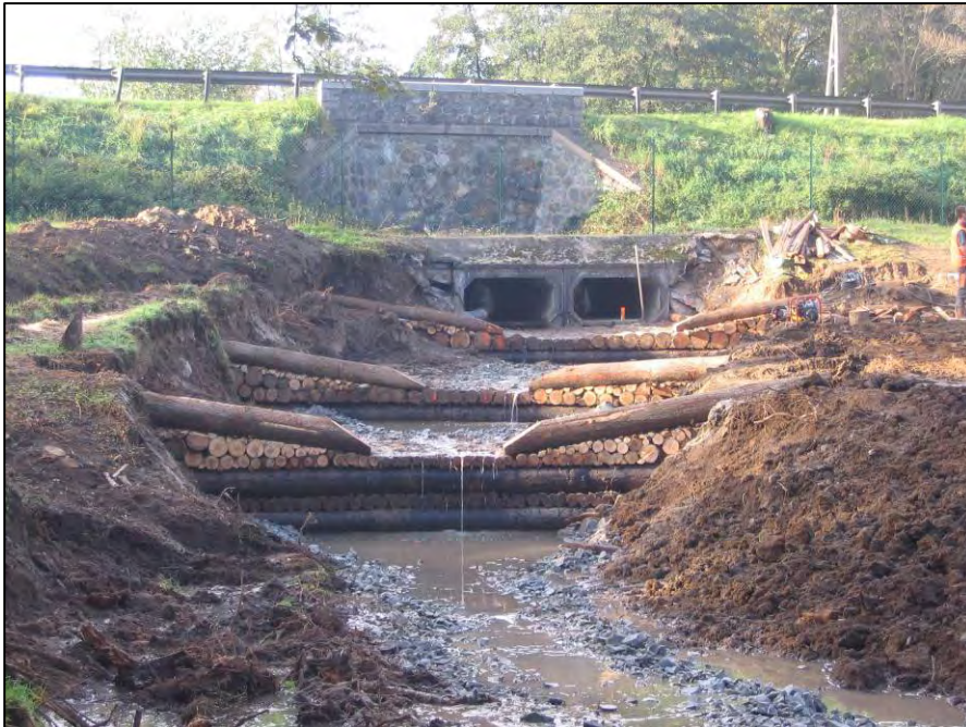
Trois barrages successifs terminés. On remarque le relèvement du fond du lit (Source : Département du Rhône, Brigades Vertes)
