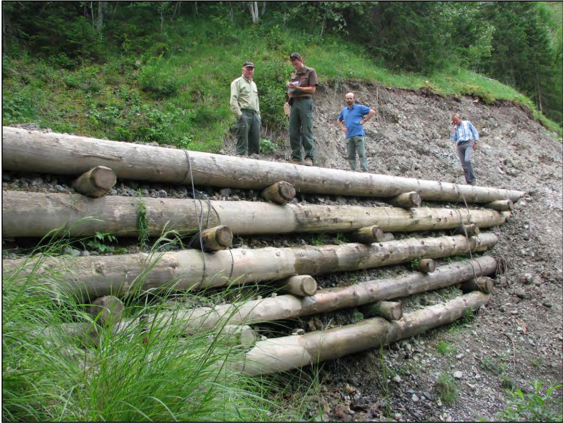
Radier réalisé en 2006 (Source : MATRINGE, 2008)
