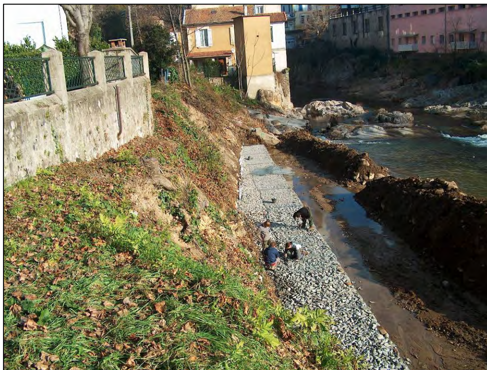
Installation du Matelas Reno (Source : Syndicat Ardèche)
