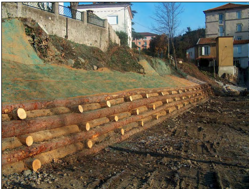
Caisson terminé (Source : Syndicat Ardèche)
