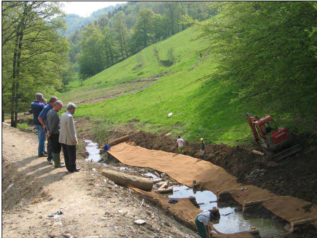
Seuils terminés. On remarque l'absence totale de végétation (Source : SMAGGA)
