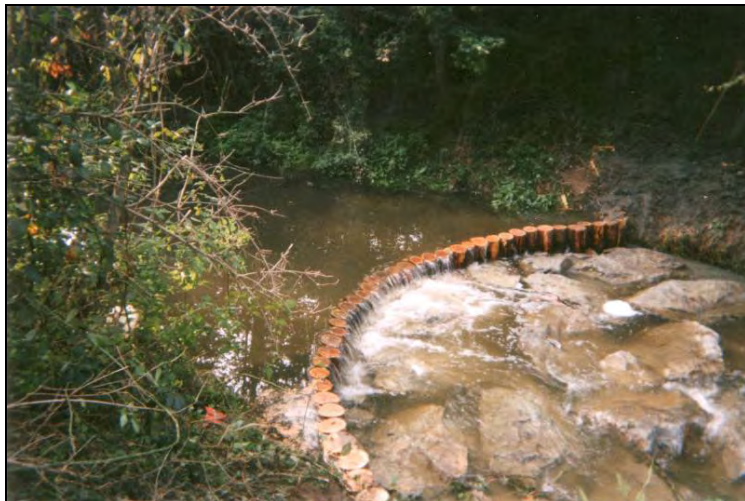
Seuil en arc de cercle et son radier (Source : Syndicat Lignon)
