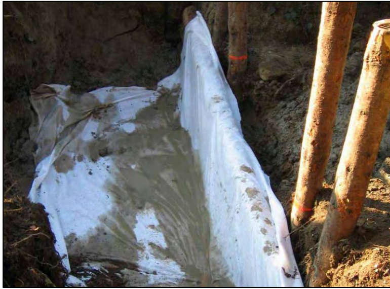
Pose du bidime avant l'atterrissement (Source : Département du Rhône, Brigades Vertes)
