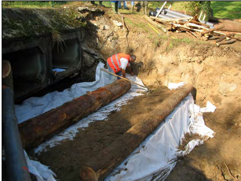
Montage d'un autre étage de la structure (Source : Département du Rhône, Brigades Vertes)
