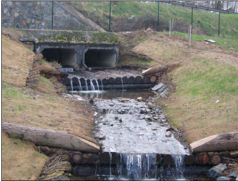
Barrages après deux mois de fonctionnement (Source : Département du Rhône, Brigades Vertes, Février 2007)
