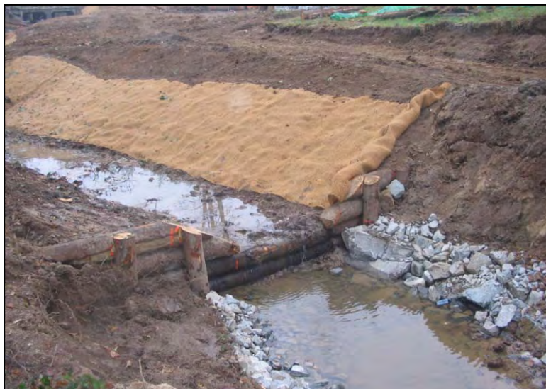
Seuil à simple paroi terminé (Source : Département du Rhône, Brigades Vertes)
