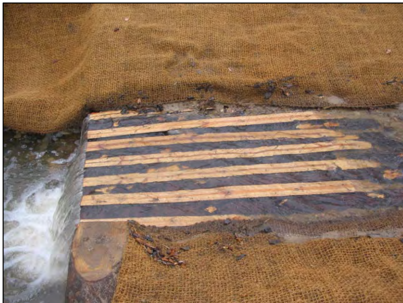
Platelage pour cuvette et remblai en amont des ailes, protégé par une toile de coco. (Source : Département du Rhône, Brigades Vertes)
