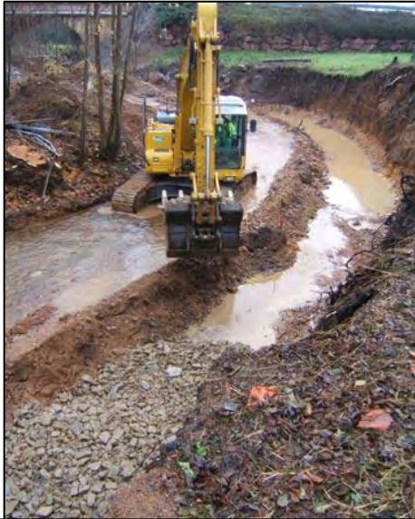
Mise en place de la semelle drainante (Source : C.C. Pays de Charlieu)
