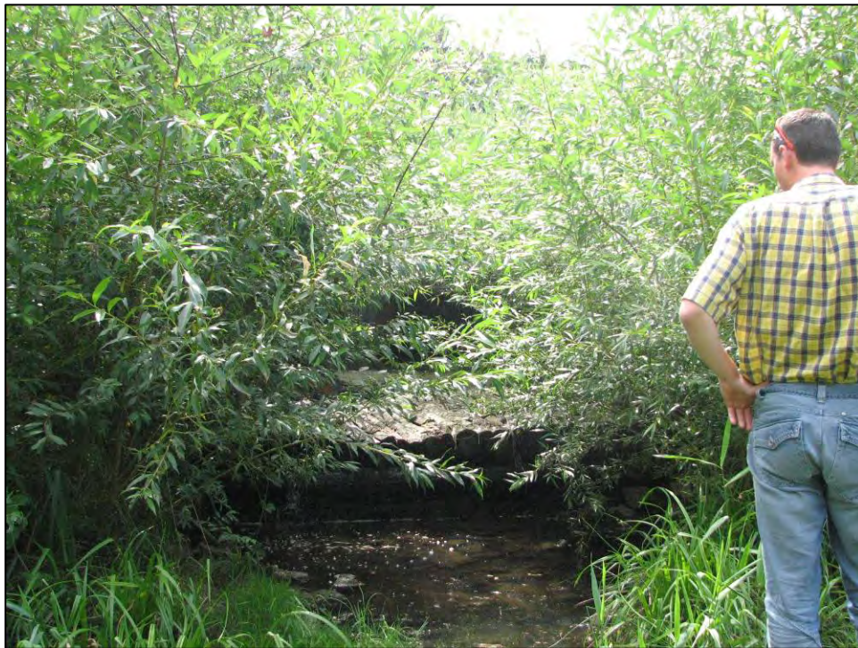
Barrages après un an et demi. On remarque la reprise efficace de la végétation. Les saules protègent les berges au niveau de la fosse de dissipation, et maintiennent une humidité et un ombrage bénéfique pour la pérennité de l'ouvrage. (Source : MATRINGE, 2008)
