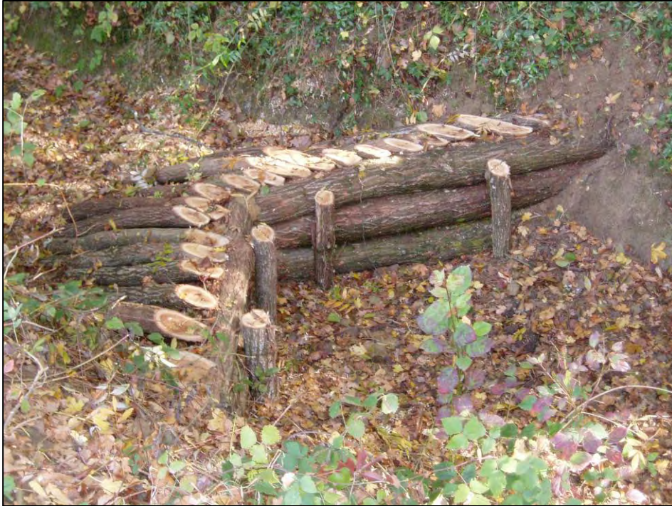
Seuil piscicole en Robinier faux acacia (Source : Syndicat de la Reyssouze)
