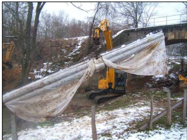
Manipulation des troncs transversaux à la pelle mécanique (Source : C.C. Pays de Charlieu)
