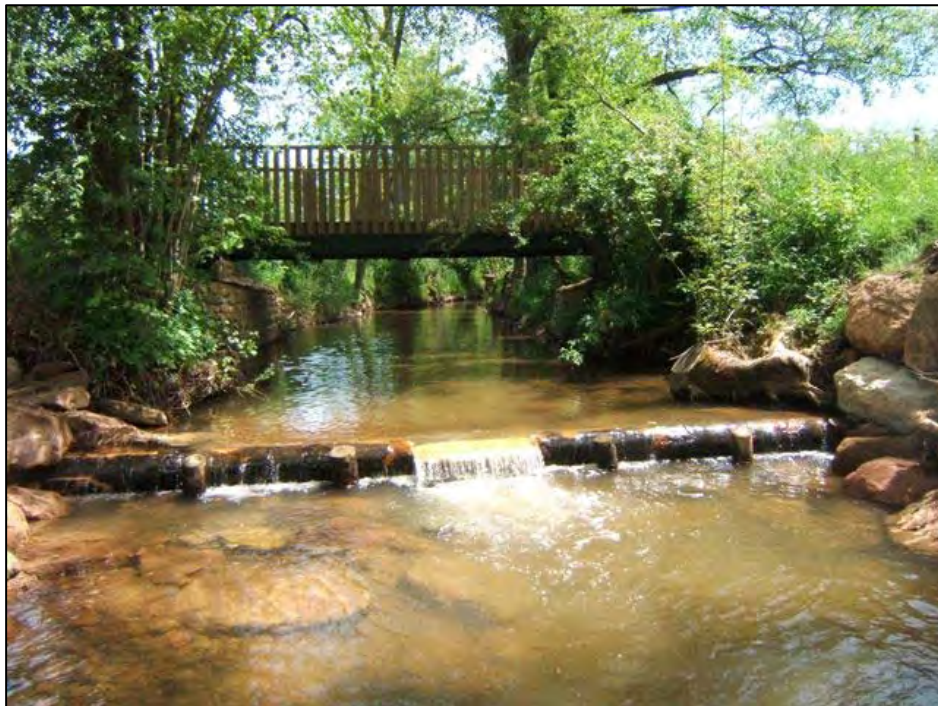
Ouvrage terminé, on peut observer la cuvette et la fosse de dissipation en enrochement. (Cliché : C.C. Pays de Charlieu)
