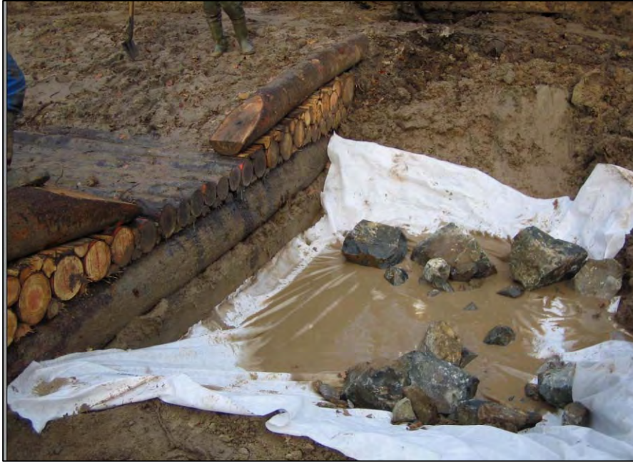
Création de la fosse de dissipation (Source : Département du Rhône, Brigades Vertes)
