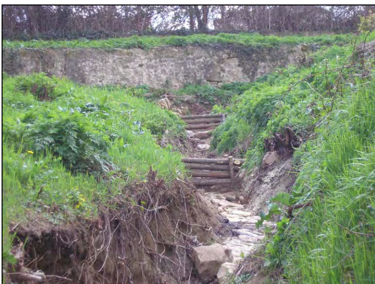
Succession d'ouvrages en terrain dégradé (Source : Syndicat de la Cèze)
