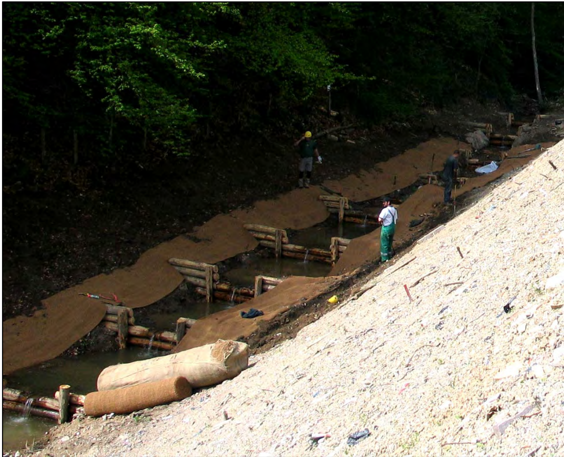
Seuils en mélèze terminés : Les berges sont reprofilées et protégées par le géotextile. (Source : SMAGGA)
