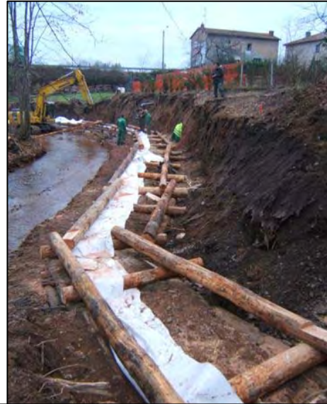
Remblais du caisson avec bidim (Source : C.C. Pays de Charlieu)
