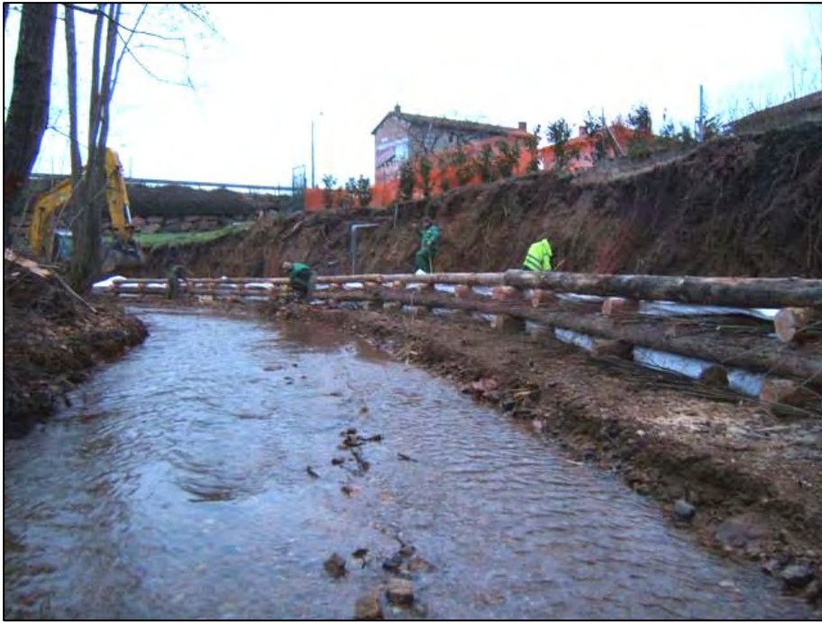
Caisson en cours de réalisation. On peut observer le bidim et les boutures de saules intégrés dans le caisson (Source : C.C. Pays de Charlieu)
