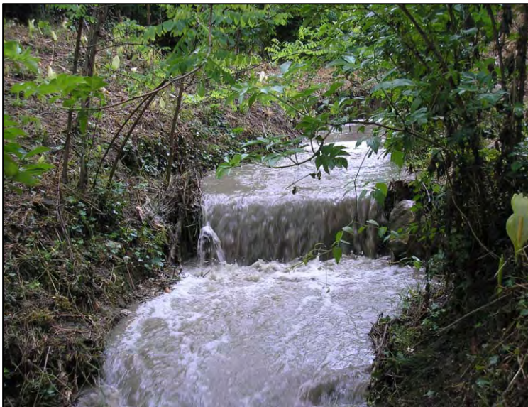
Ouvrage avec écoulement (Source : Syndicat de la Cèze)
