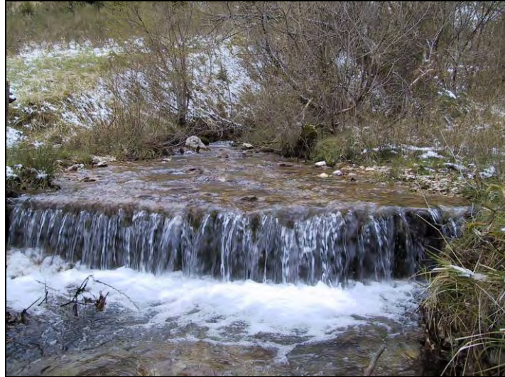
Seuil piscicole (Source : Syndicat Mixte de la Rivière Drôme)
