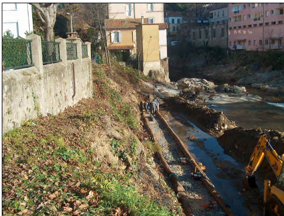
Pose de la première rangée de longirons (Source : Syndicat Ardèche)
