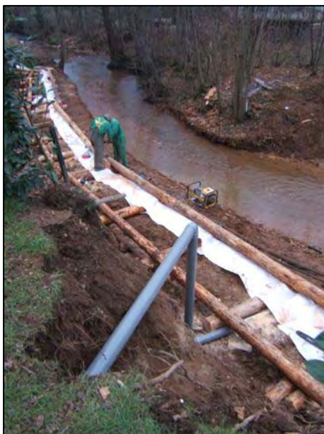
Mise en place de la semelle drainante (Source : C.C. Pays de Charlieu)
