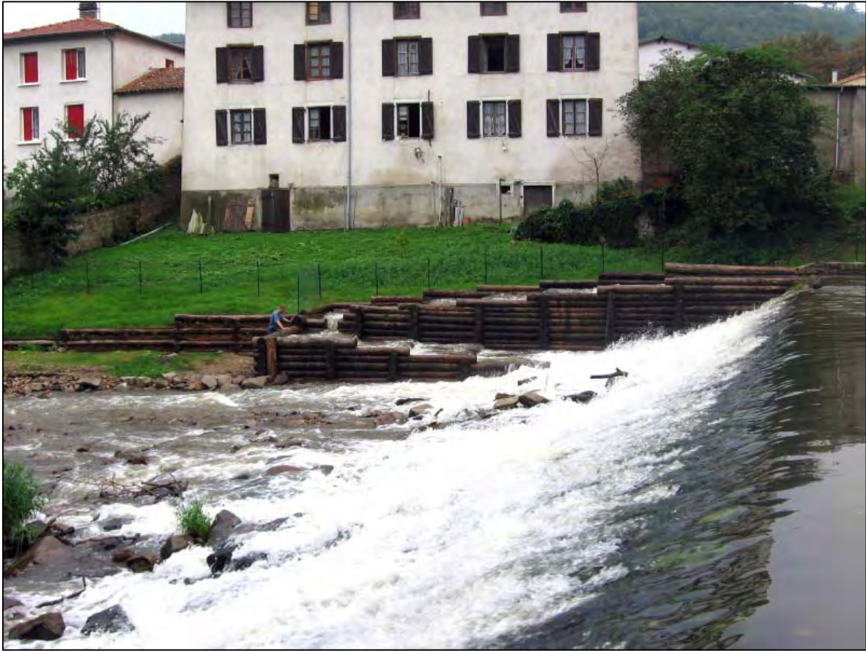
Passé à poisson terminée avec le caisson en continuité aval (Source : Syndicat Lignon)
