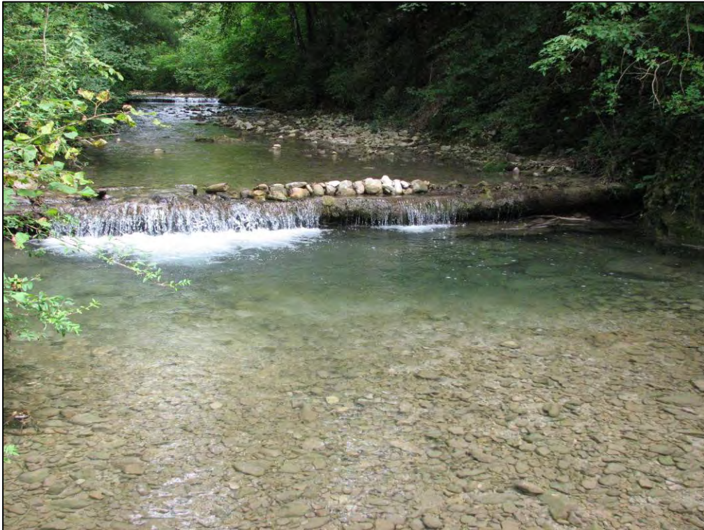
Ouvrage et fosse de dissipation (Source : MATRINGE, 2008)
