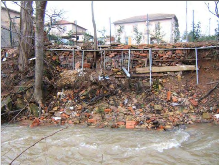
Site avant travaux. (Source : C.C. Pays de Charlieu)
