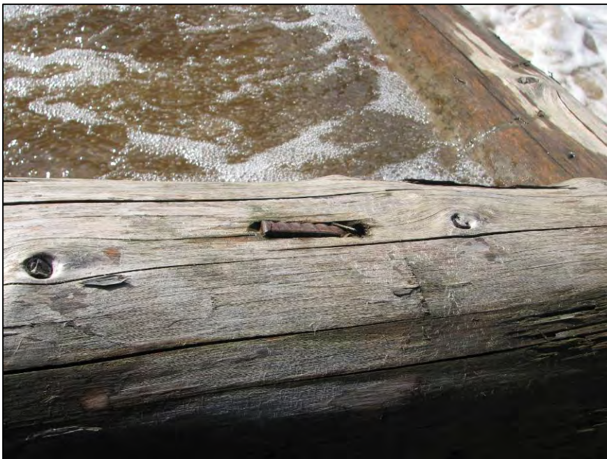
Fixation des troncs à l'aide de fer à béton (Source : MATRINGE, 2008)
