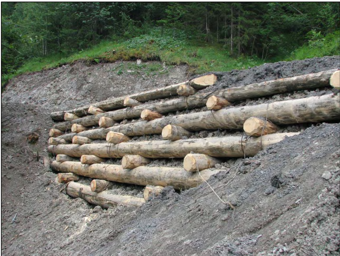
Radier réalisé en 2008 (Source : MATRINGE, 2008)
