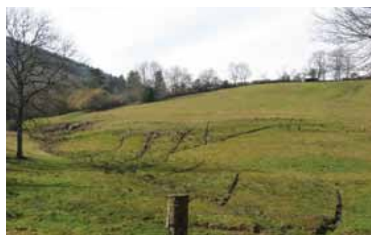
▲ Réseau de rigoles entretenues.
