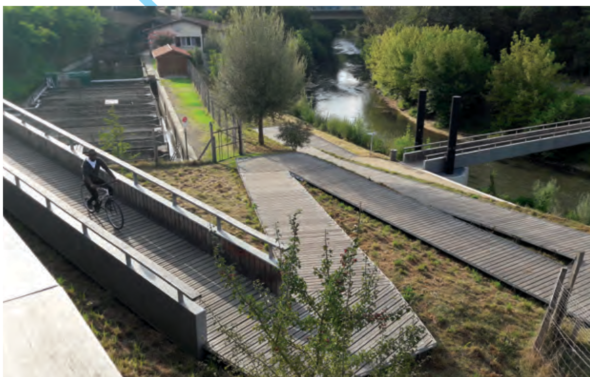
Passerelle sur les bords de la Midouze
