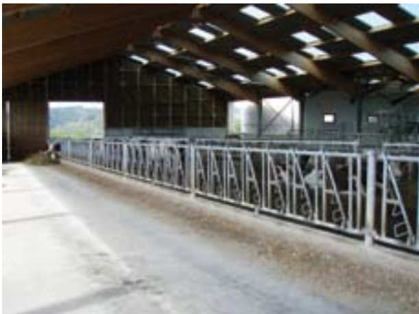
Bâtiment de l'exploitation © Mickaël Chapelle
