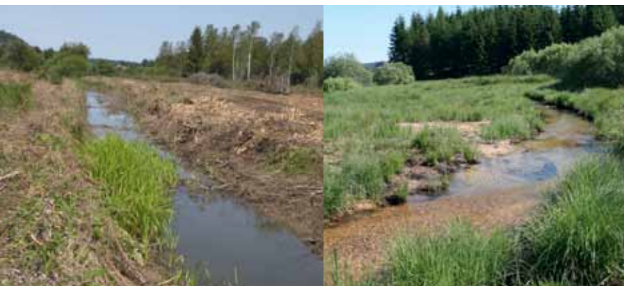
Les travaux sur la Lemme.
