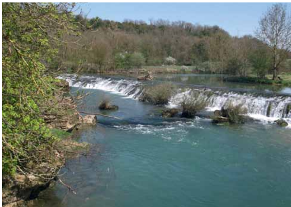
▲ Seuil faisant obstacle au passage des poissons.
