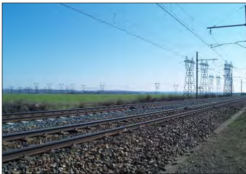
Voie ferrée à Saint Bonnet de Mûre
