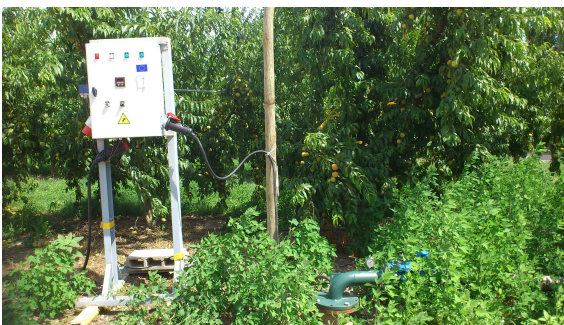
Photographie 2 : Remplacement d'une pompe de surface par une pompe immergée avec compteur placé hors d'eau, Mondragon (Vaucluse) - Source : Chambre d'agriculture de Vaucluse
