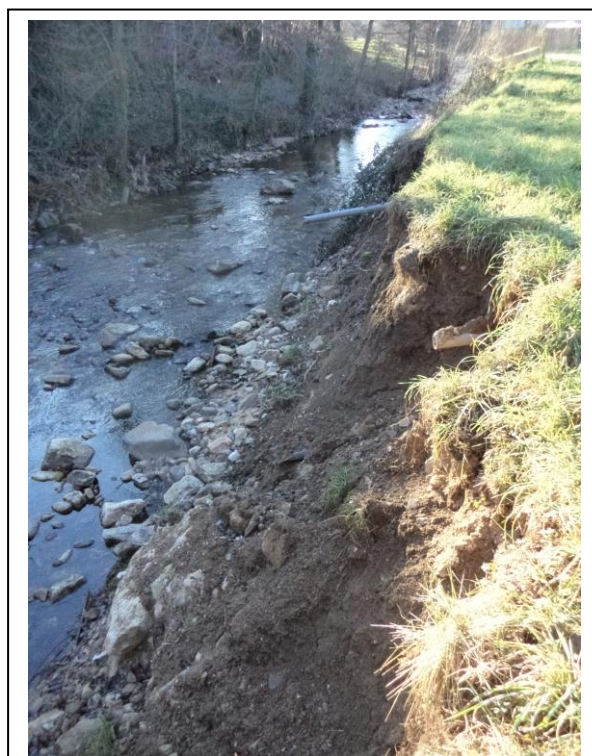
Figure 1 et 2 : berge érodée rive gauche de l'Ay, sous le bâtiment de tennis
