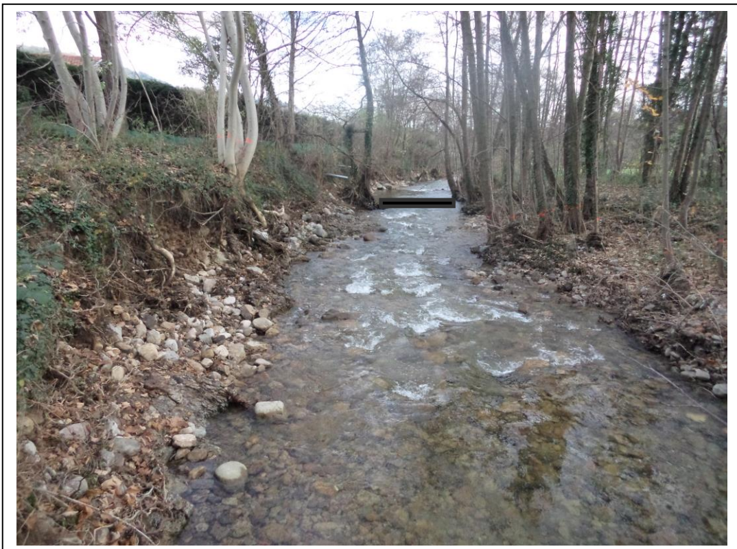
Figure 4 : Aperçu de la rive gauche érodée et du micro-seuil à créer (en noir)
