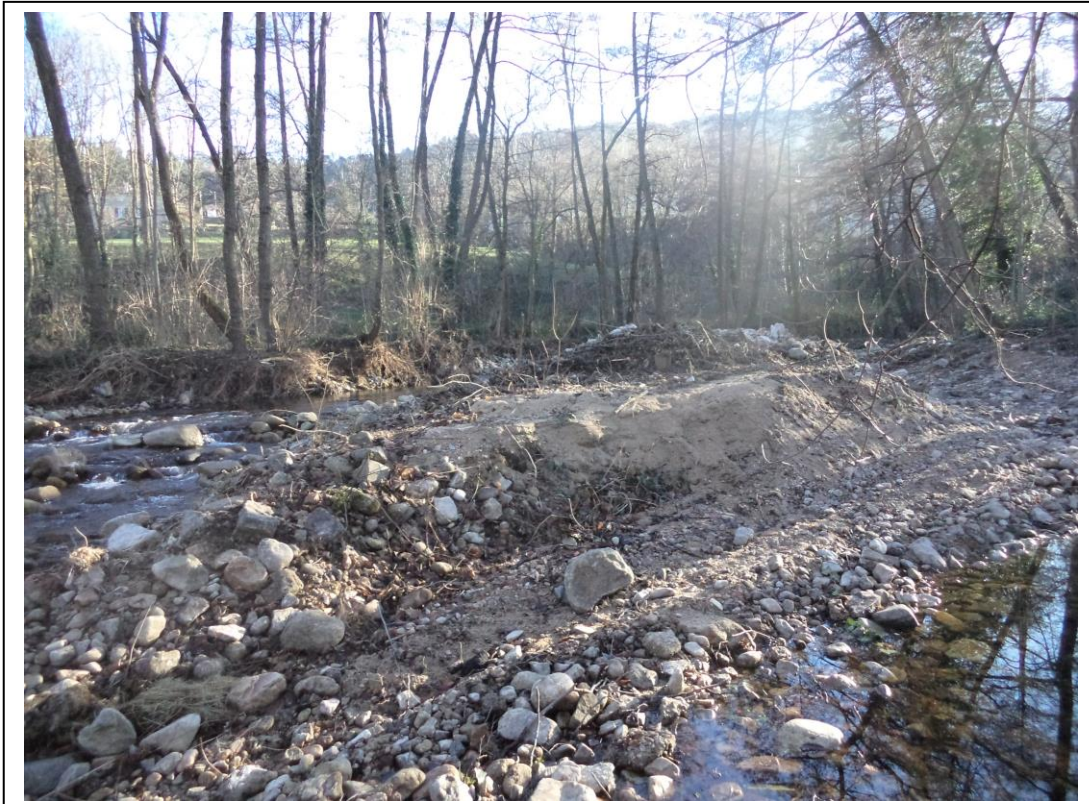
Figure 3 : Aperçu de l'atterrissement à réduire, griffé et régalié sur la berge gauche aval
