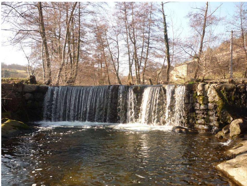
**Figure 1 : Exemple d'ouvrage perturbant le transit sédimentaire : le seuil de Palochon sur l'Ay**
