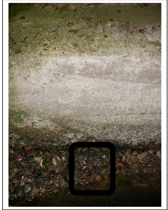
Du génie civil est à prévoir pour encrener l'échelle dans le socle béton
