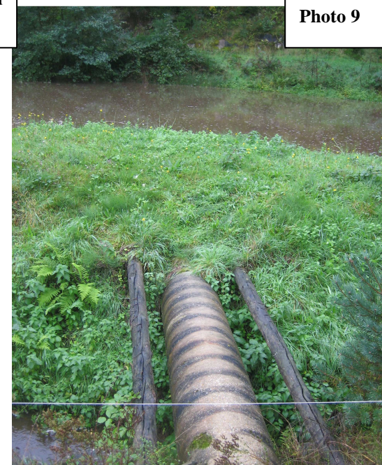
— Canalisation enterrée acheminant le ruisseau de Crouzet dans la retenue
