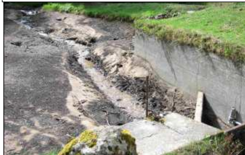
Photo 7, 8 et 9 : Départ, cheminement et arrivée de la dérivation du ruisseau de Crouzet dans la retenue.
