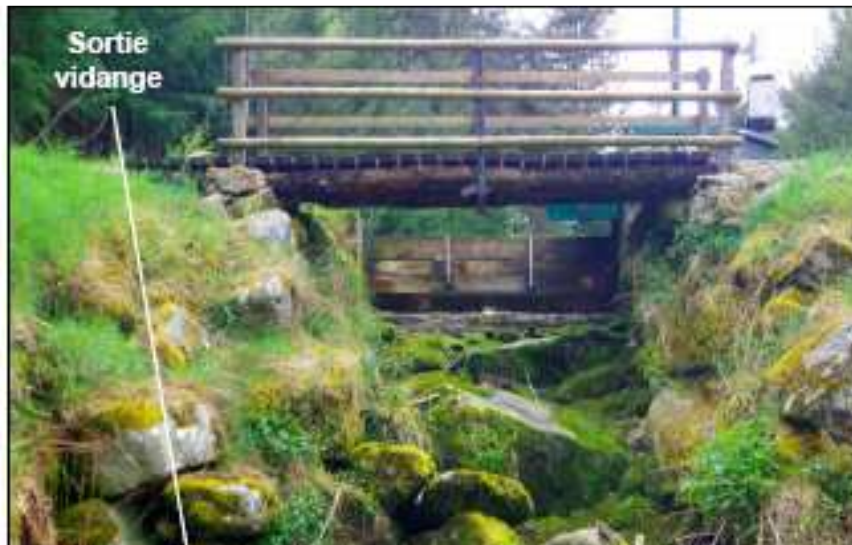
Photo 3 : Le barrage principal vu d'aval, avec le batardeau servant de déversoir
