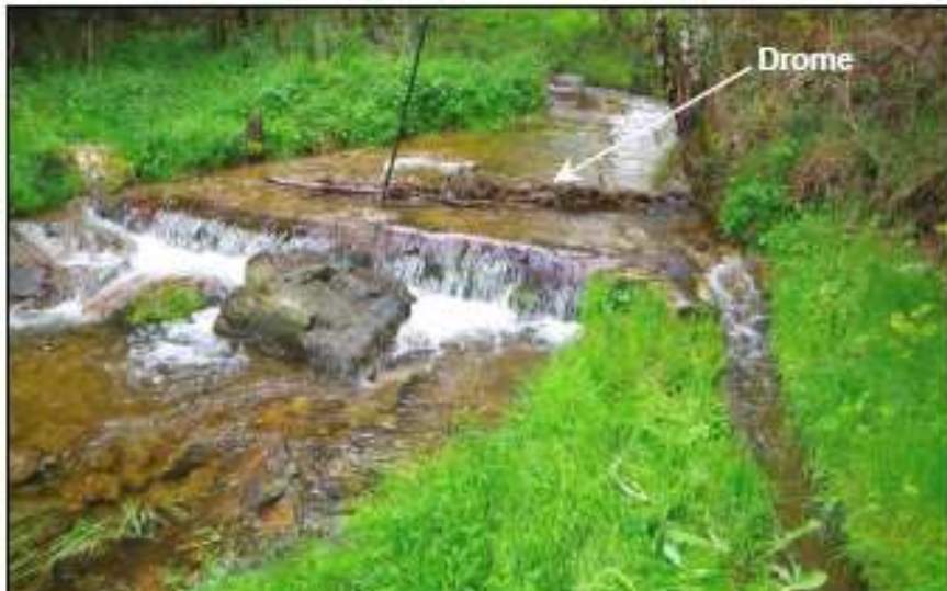
Photo 1 : Seuil amont. A droite la prise du débit réservé (passe à poissons)
