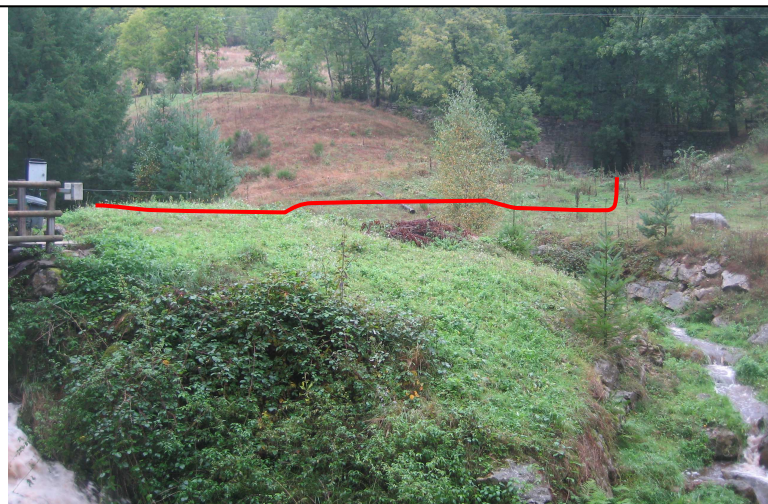
— Canalisation enterrée acheminant le ruisseau de Crouzet dans la retenue
