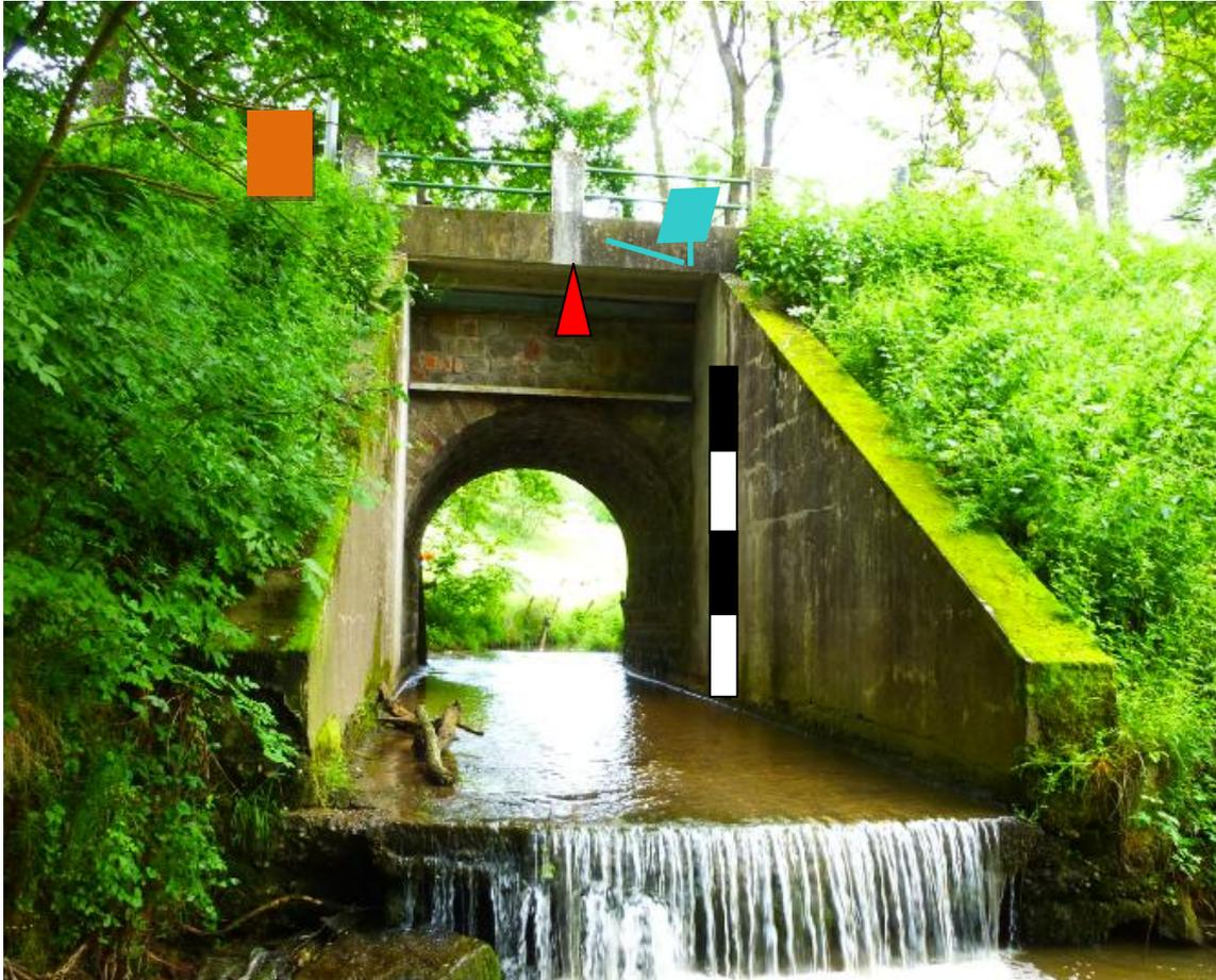
*Section aval du pont avec positionnement indicatif du radar, de l'armoire, du panneau solaire et de l'échelle*
