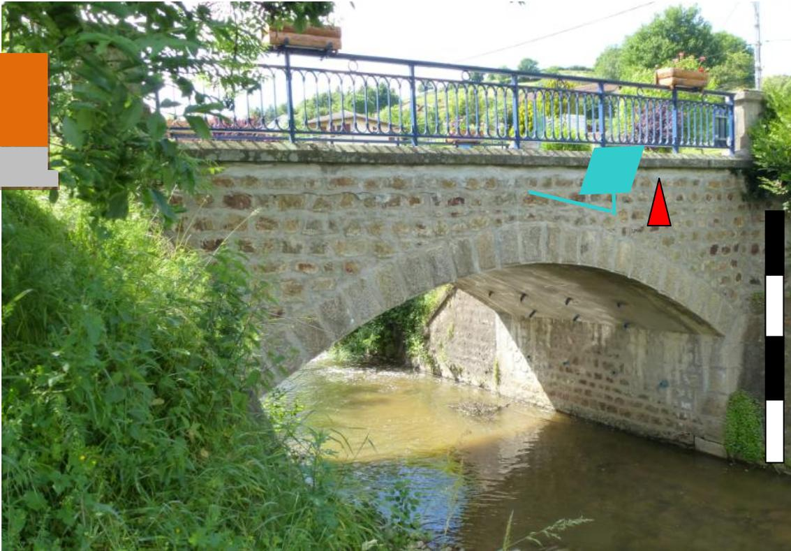
*Positionnement indicatif du radar, de l'armoire, du panneau solaire et de l'échelle*
