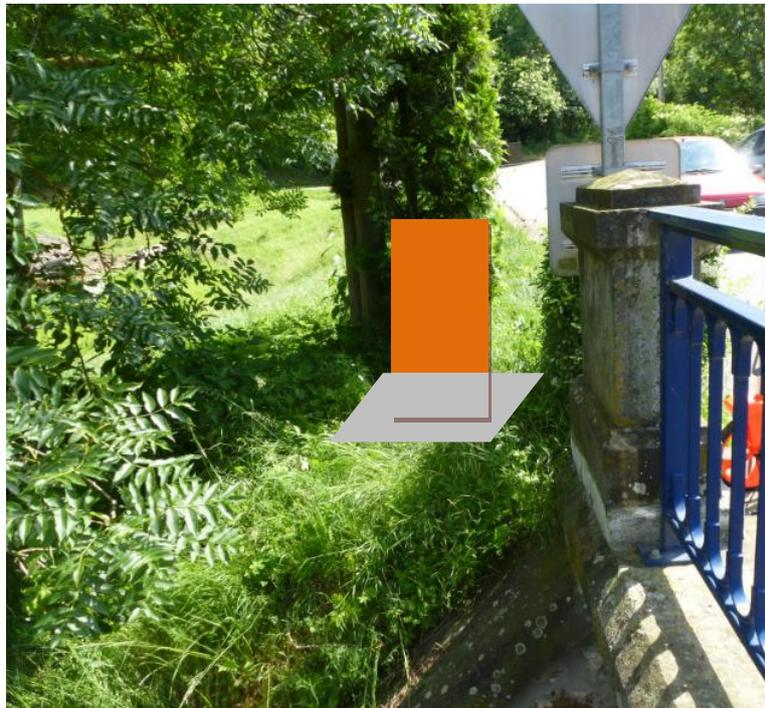
*Positionnement indicatif de l'armoire en rive droite sur socle béton*
