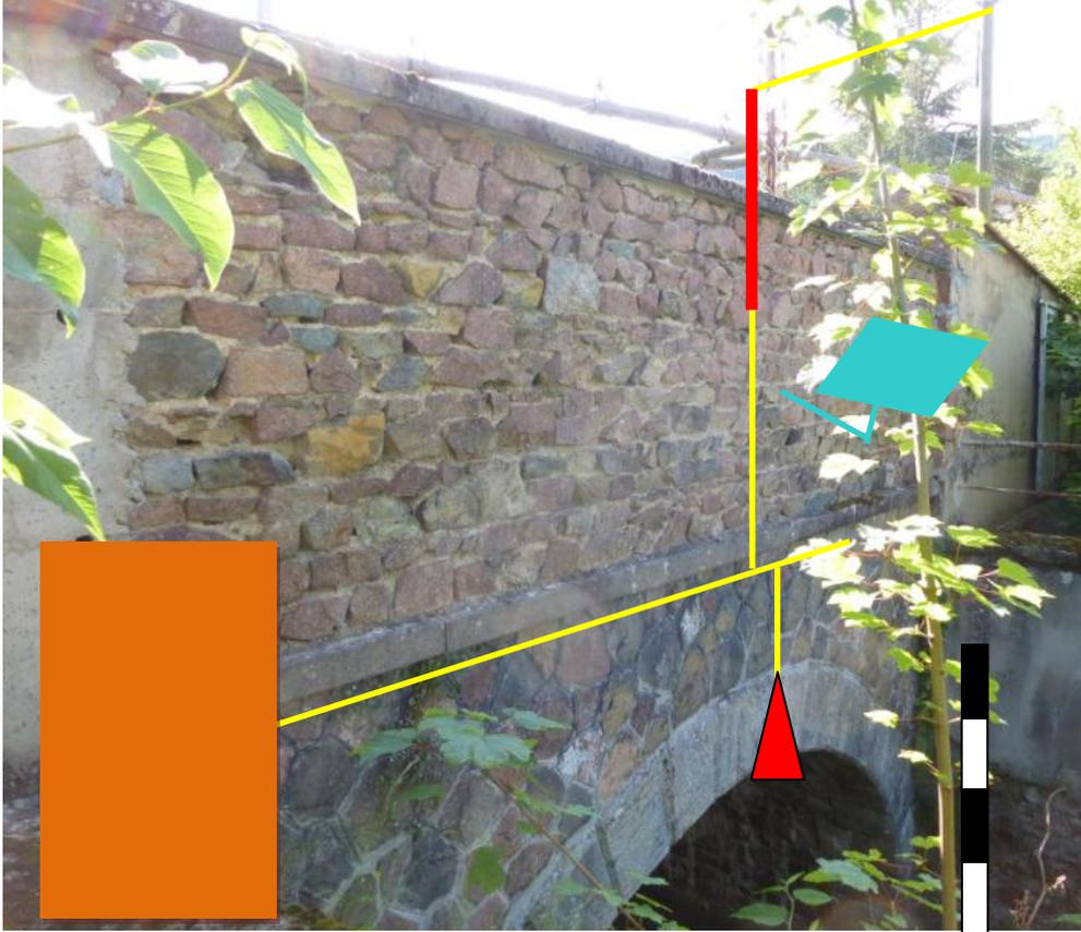
*Positionnement indicatif du radar, de l'armoire, du panneau solaire et de l'échelle*
