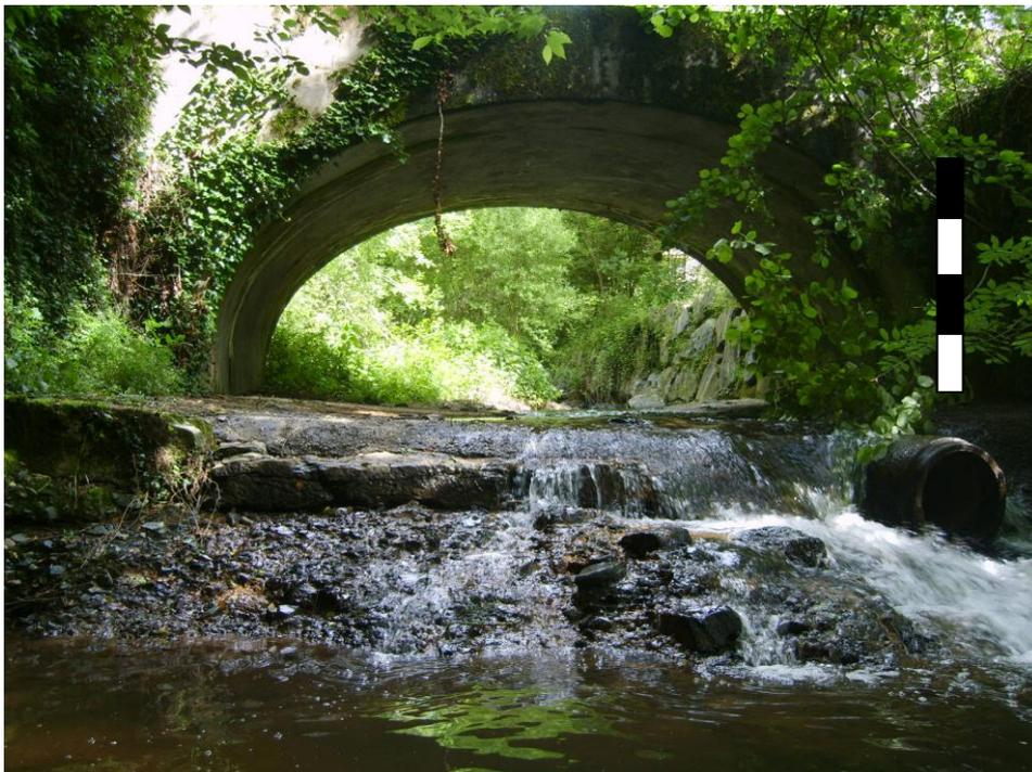
*Section aval du pont calée par un seuil : échelle à positionner en rive gauche*
