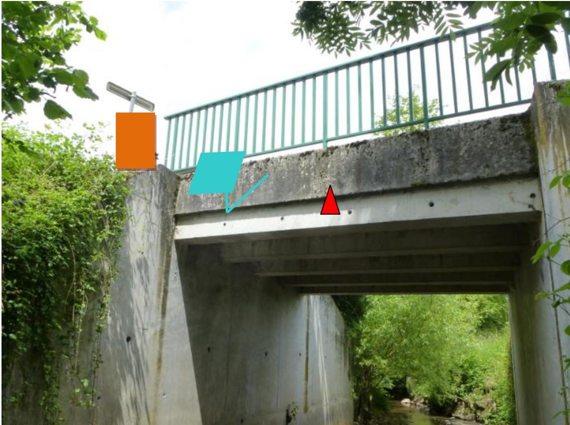
*Positionnement indicatif du radar, de l'armoire et du panneau solaire*
