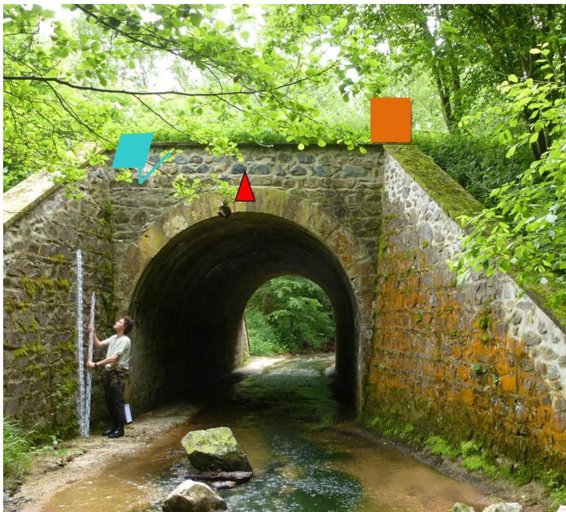
*Section amont du pont avec positionnement indicatif du radar, de l'armoire et du panneau solaire*
