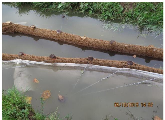
Aucun géotextile non biodégradable (bidim, géotextiles synthétiques...) ne sera accepté.
