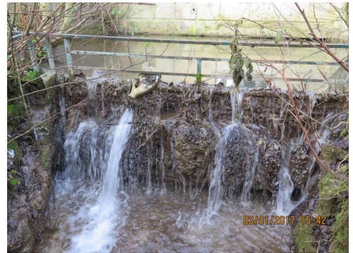
Photo 4 : Concrétionnement de la grille du bras usinier
