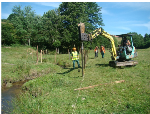
Battage des piquets de clôture
