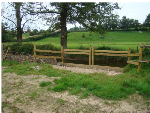
Abreuvoir à 6 pieds avant empierrement
