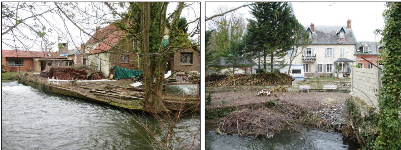
Figure 5 : Berges à restaurer sur la propriété du moulin de la Moulinière
