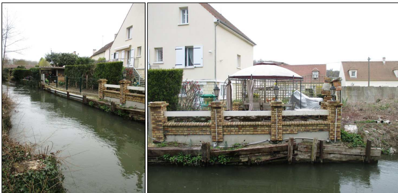
Figure 6 : Berges à restaurer sur la propriété en amont immédiat du moulin de la Moulinière
