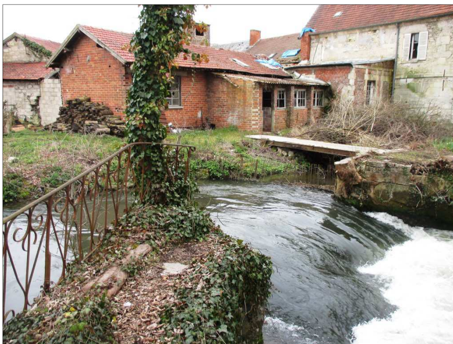
Photo 1 : Photographies du seuil du moulin de la Moulinière (BURGEAP, juillet 2016)
