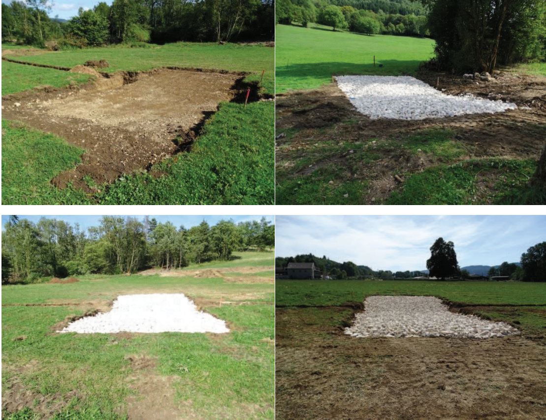
Illustrations de la mise en œuvre des passages à gué
