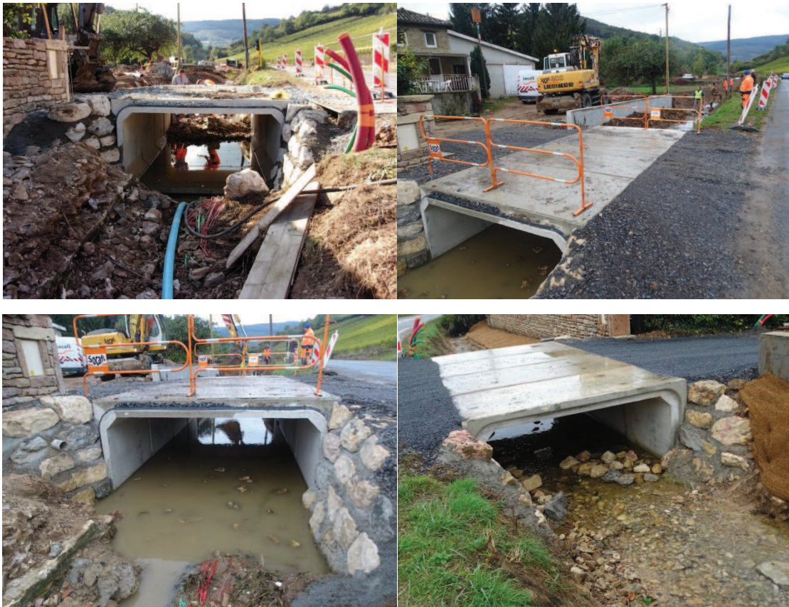
Mise en œuvre de pont cadre « ponts agricoles »
