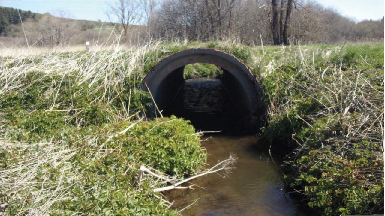
Buse calée correctement n'occasionnant pas de chute
