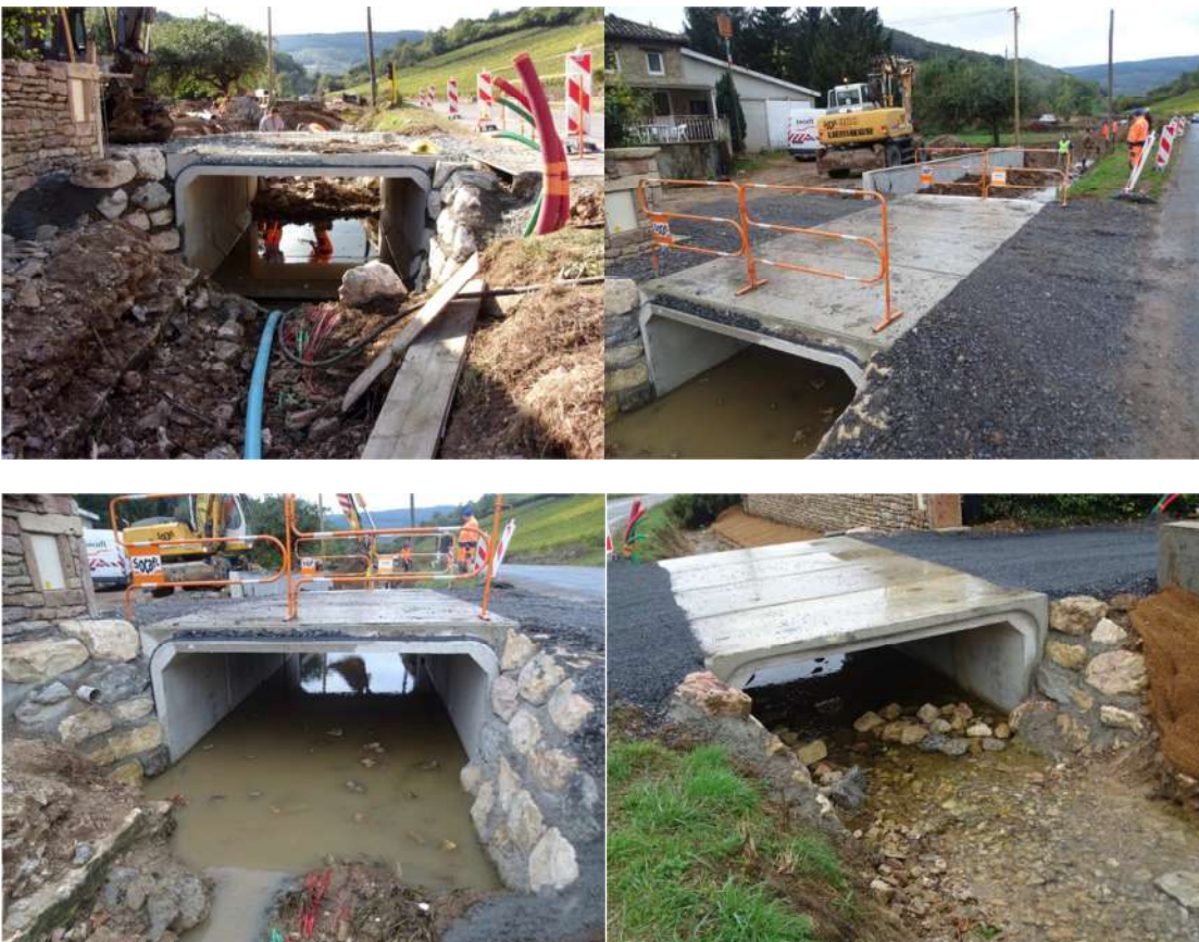
Figure 25 - Mise en œuvre de pont cadre « ponts agricoles »
