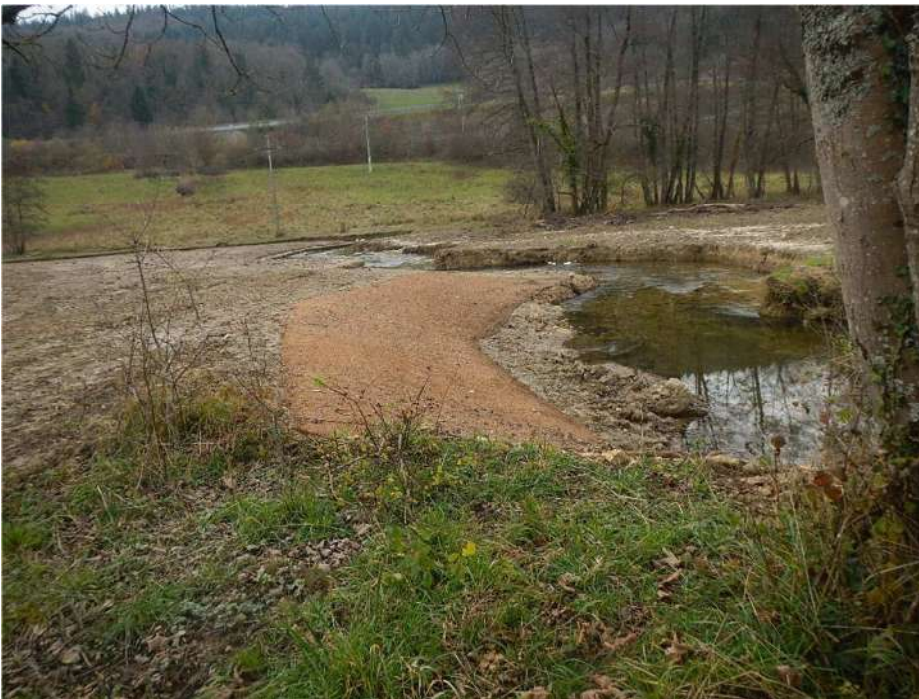
Figure 15 - Exemple de bouchon hydraulique
