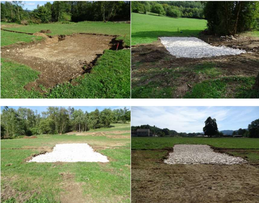
Figure 27 - Illustrations de la mise en œuvre des passages à gué
