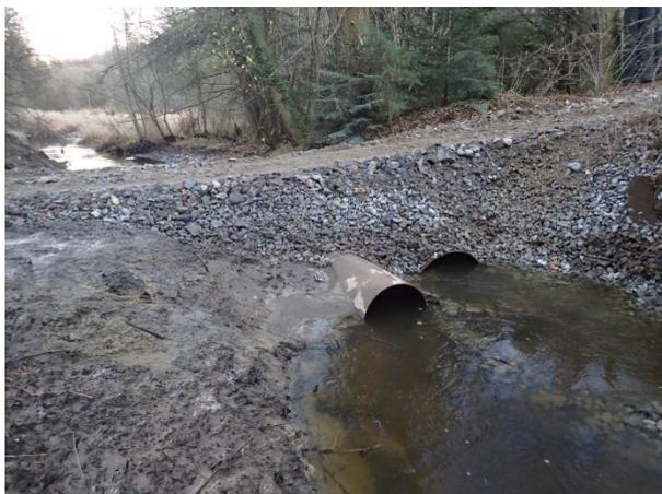
Figure 16 : Exemple de buses et passage d'engin
