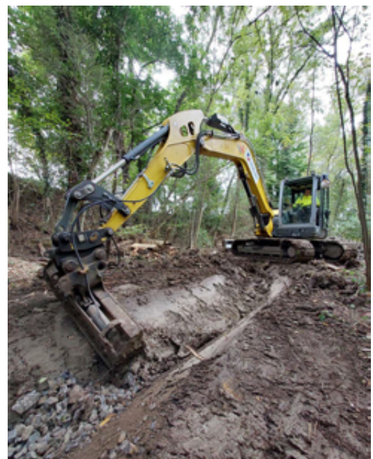
Pelle utilisée pour la réalisation des travaux (14 octobre 2025 - ©SMVVA)
