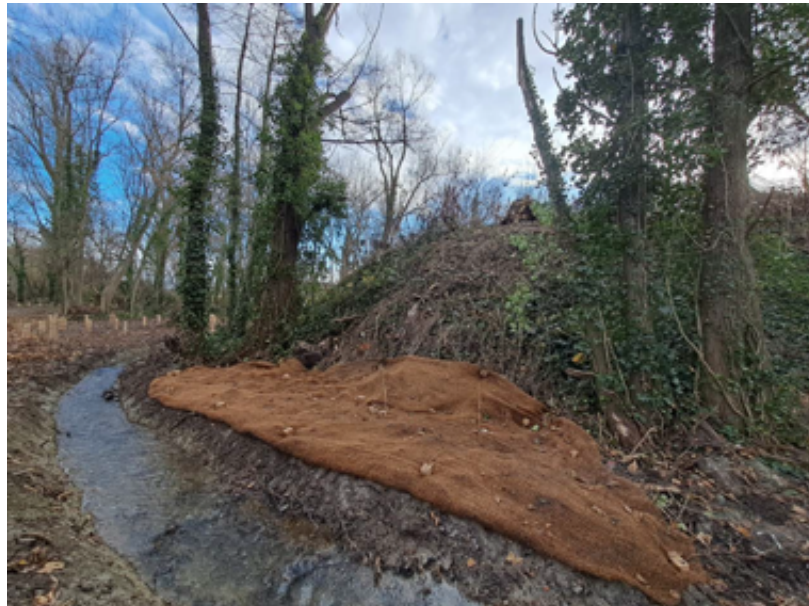
Protection de la décharge et système de lutte contre la renouée fait en couche de branches de saules (16 décembre 2025 - ©ARRA²)
