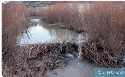
Les **Ouvrages type Castor** (ou castor-mimétiques) sont des structures artisanales destinées à imiter et encourager les processus générés par les activités de construction des castors. Ce sont des structures perméables enjambant le chenal, caractérisées par une crête d'élévation régulière.
