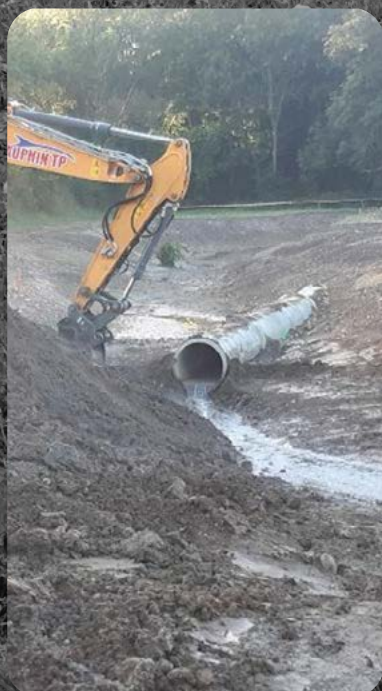
Enlèvement du busage sous-terrain
