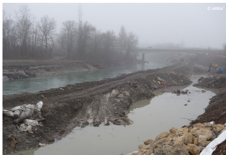
Travaux en cours en février 2022
