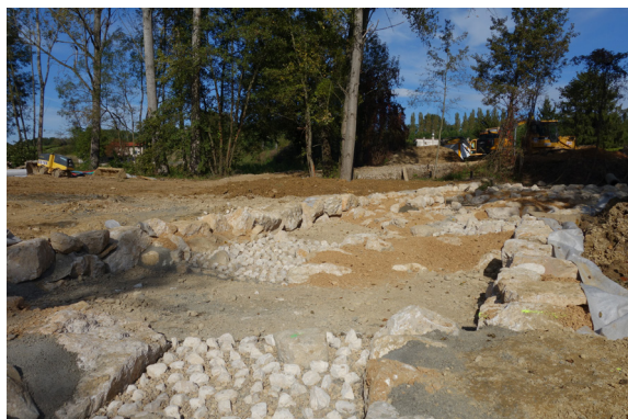
Passe à poisson en cours de travaux
